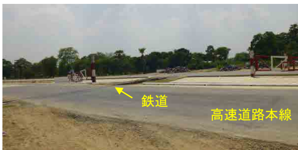
高速道路と鉄道が、平面交差している 手動で動かす遮断器がある
