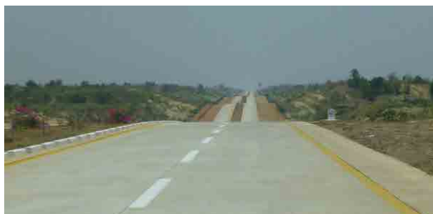
片側2車線の高速道路(100km/規制) (コンクリート舗装)
