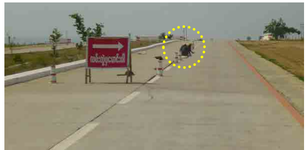
1車線規制。センターレーンマーク補修
