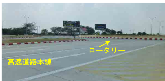
マンダレー近郊では、ロータリー形式の出入口を有しているため徐行が必要 (本線の規制速度は 60km/h)
