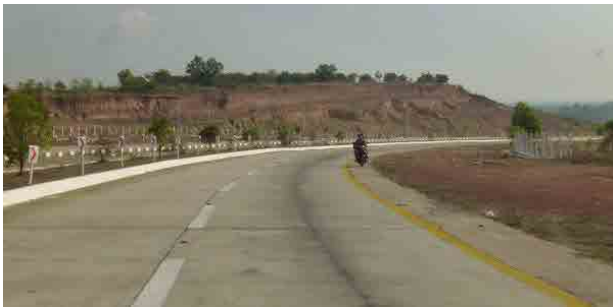
線形の悪い箇所では、矢印板が設置されている。(バイクは逆送中)
