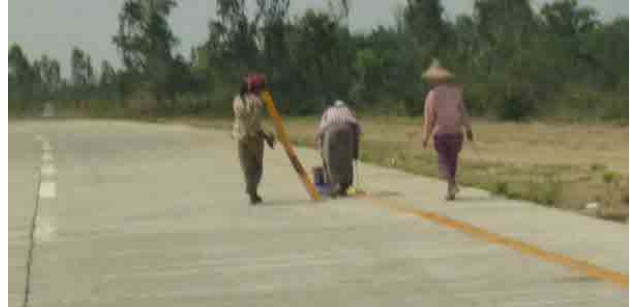
レーンマークの補修工事 規制なし。交尾警戒員はなし。
