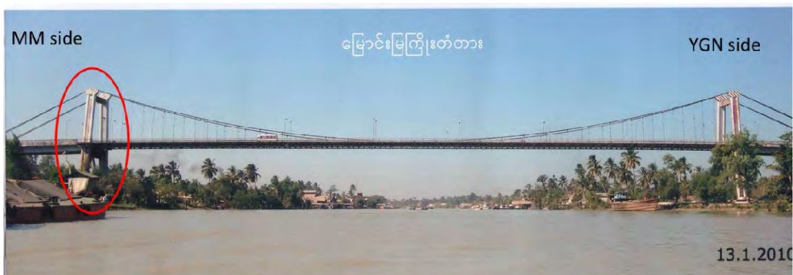
写真 3.2 下部工移動の例(Myauungmya 橋)
