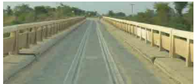
RC単純桁：鉄道と道路が兼用となっている
