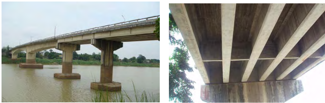
写真 2.2 ナウワン橋（左：全景、右：アプローチ部桁下）（2012年5月撮影）
