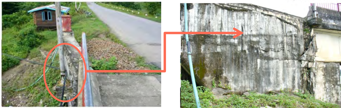
写真 3.1 下部工移動の例(Maubin 橋)
