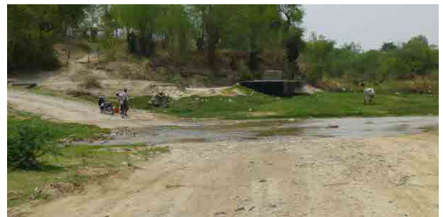
橋梁がない箇所あり 越流橋(コンクリート板)として整備も進められていた
