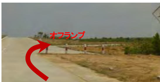
写真 3.16 連絡等施設の分合流部
