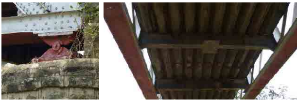
デッキプレート床版によるトラス橋
