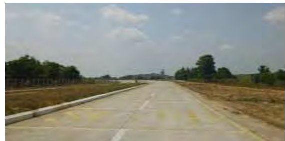
写真 3.17 本線の曲線部
