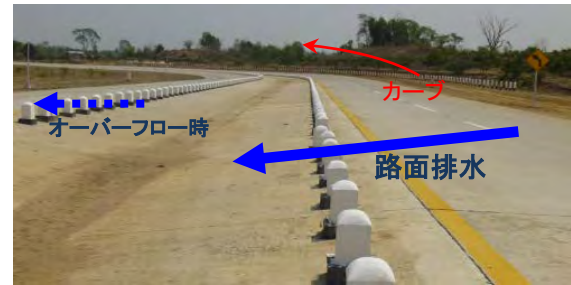
写真 3.19 曲線部の簡易な中央排水施設
