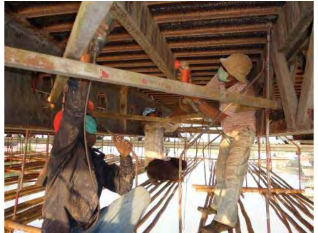
写真 3.7 Myaungmya 橋の塗装塗替え(素地調整)
