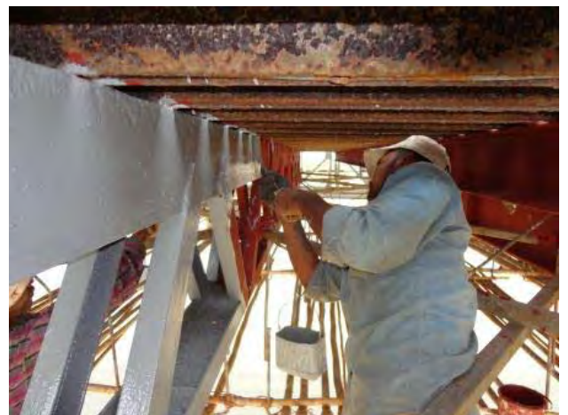
写真 3.9 Myaungmya 橋の塗装塗替え(2層目)
