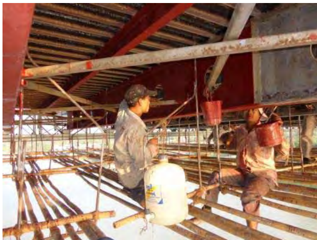
写真 3.8 Myaungmya 橋の塗装塗替え(1層目)
