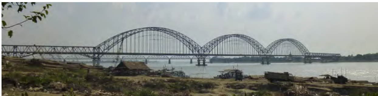
手前がAyeyawady橋（Yadanabon）。奥がInwa橋
