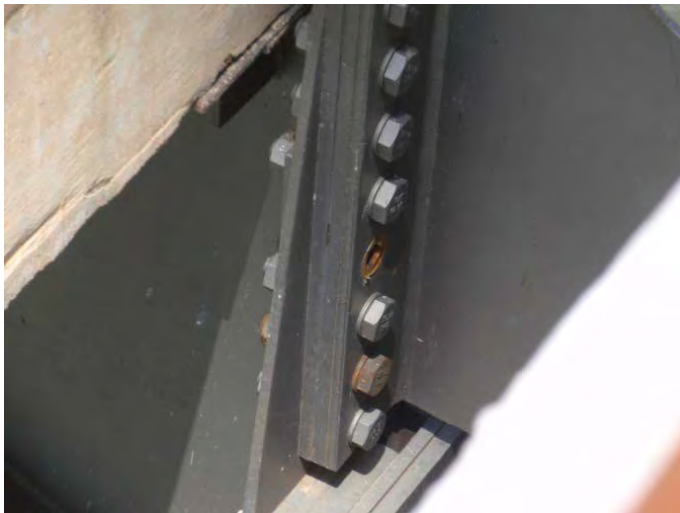
写真 3.4 高力ボルト欠落の例 (Yadanarpon 橋)
