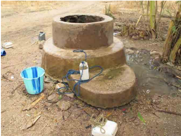
【写真-07 伝統水源—コンクリート製浅井戸】 コンクリート製浅井戸、深井戸に比較すると水質汚染の危険性がある。 (北部州ンドジャ村)
