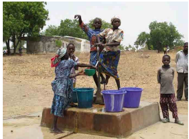
【写真-11 ベルニエポンプ付き深井戸】 (足踏みポンプ)
