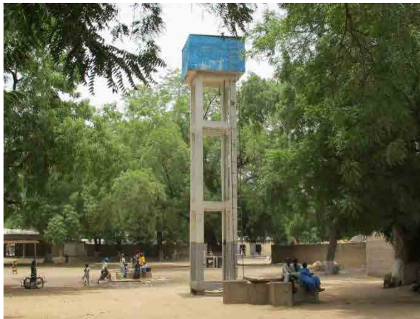
【写真-14 地方都市の給水網施設—高架水槽】 深井戸を水源とする給水網施設。ペテ市が管理 (極北州ペテ市)
