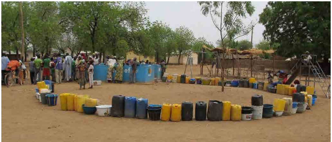
【写真-09 近代的水源】 人力ポンプ付き深井戸に並ぶ順番待ちのポリタンク、50 家族が利用しており、他に深井戸がないため待ち時間が長い。(極北州 ガヤク ルムデ村、既設深井戸、UNICEF 建設)
