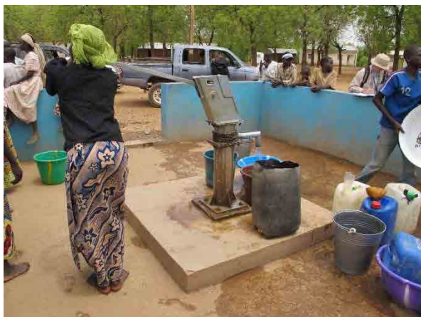
【写真-10 India Mk II ポンプ付き深井戸】 (手押しポンプ、上の写真の内部)
