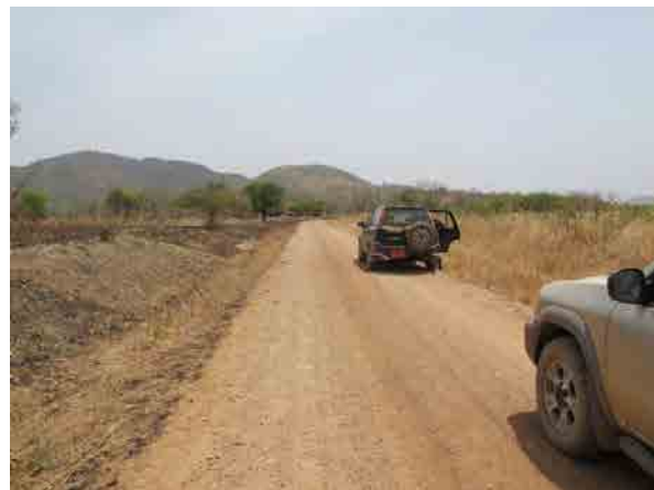
【写真-16 道路状況】 北部州マヨ ウーロ市 ～ガルア市間の州道1号線、ラテライト舗装で、 40～60km/時程度で走行可能
