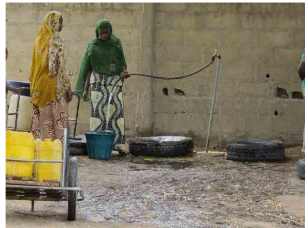
【写真-15 同左、公共水栓】 単純な構造で排水処理施設もない。
