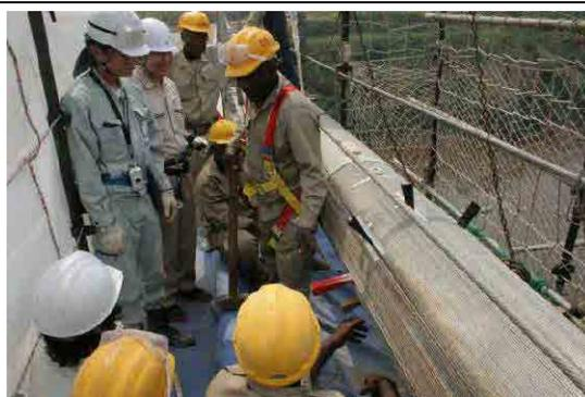
写真 3-38 八方向からのくさびをほぼ打ち込み終わった状況
