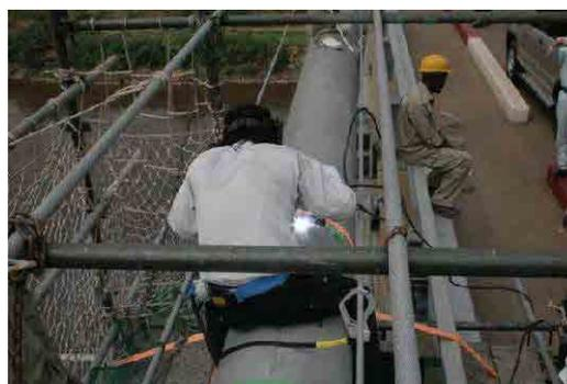
写真 3-14 最終点のスポット溶接による留め
