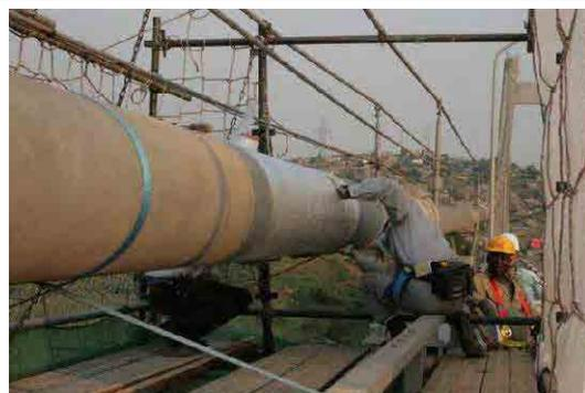
写真 3-28 作業後にケーブルに雨がつかないようにビニールでラッピング。13日の朝に、内部が結露していなかった。日本では結露することが多い。
