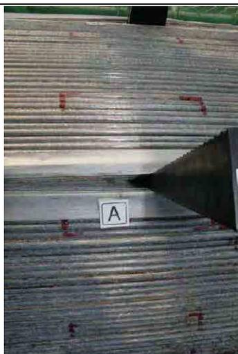
写真 3-39 主ケーブル上面の内部状況。白錆が発生しているのみで状態は良い。しかし内部の奥まで白錆は発生している。
