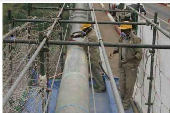
写真 3-30 ブロワーによる細かいペースト片の除去
