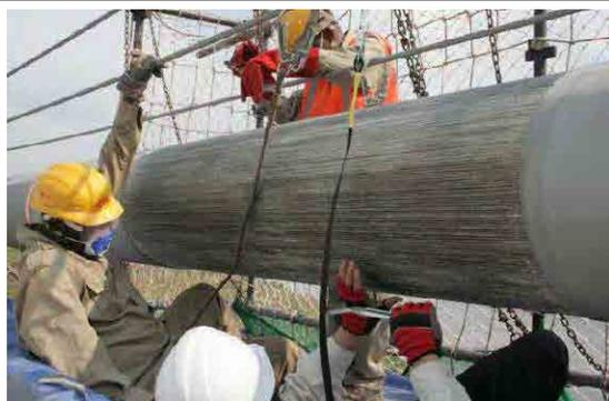
写真 3-46 主ケーブル開放調査後、再ラッピングする前にケーブル素線に有機ジンクリッチペイントを塗装するので、その前にワイヤブラシ、電動ワイヤブラシ等で錆を落とした。(この写真は下流側主ケーブルの作業状況で代用)
