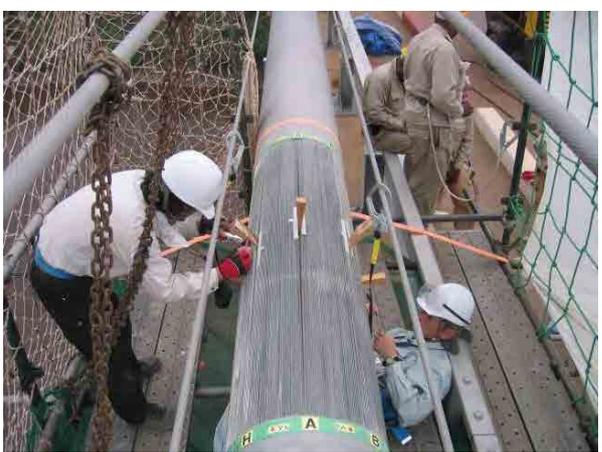
写真-9 主ケーブルの8方向ケーブル内部調査状況
