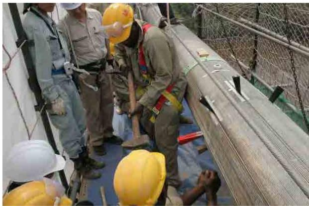
写真 8 OEBK 所有の大型ハンマーによるくさび打ち込み作業
