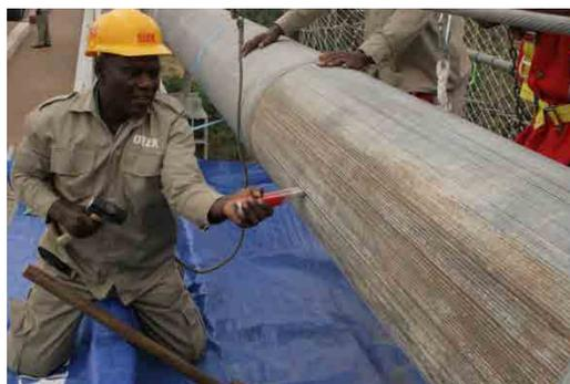
写真 3-45 くさびの撤去
