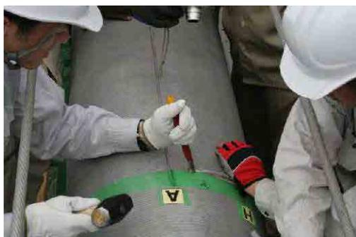
写真 3-13 タガネによるラッピングワイヤーの切断
