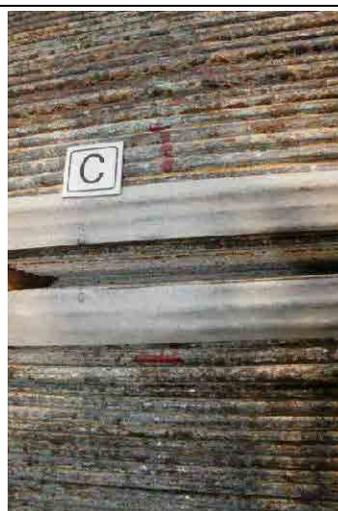
写真 3-40 上流側側面の内部。赤錆びもかなり発生しており、内部も奥まで同様の状況である。
