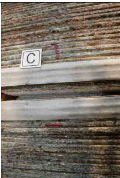
写真 10 上流側側面の内部。赤錆びもかなり発生しており、内部も奥まで同様の状況である。
