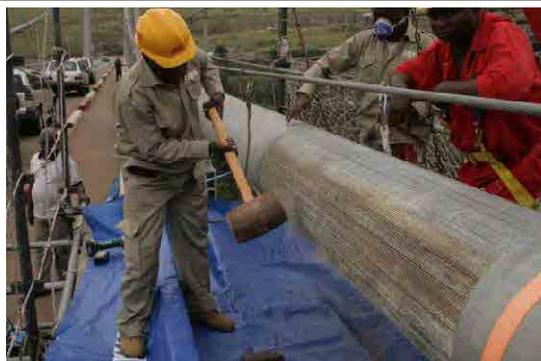
写真 3-47 建設時のケーブル整形に使用したカケヤ(30年前のもの)を使用してケーブル内のラッピングペーストの埃を落とした。
