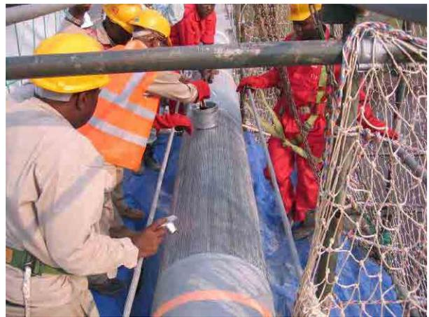
写真-14 主ケーブル表面を有機ジンクリッチ塗料で塗装
