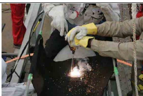
写真 3-49 既存のワイヤとこれから巻くワイヤとの溶接による接続。(下流側主ケーブルでの作業写真で代用)
