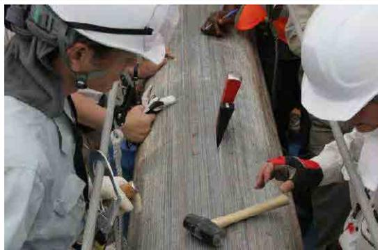
写真 3-35 ハンマーによるくさびの主ケーブル内への打ち込み
