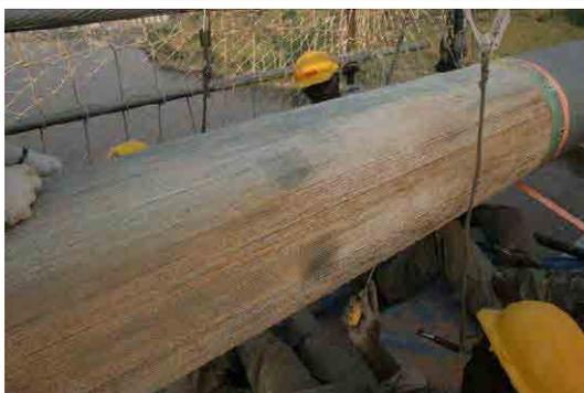
写真 3-27 ラッピングペーストの除去、ドライバー等を使いペーストをこそげ落とす。大変な労力のいる作業であった。
