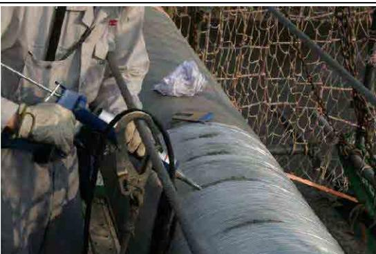
写真 3-53 隙間の開いているところをコーキング材で(下流側主ケーブルでの作業の写真で代用)
