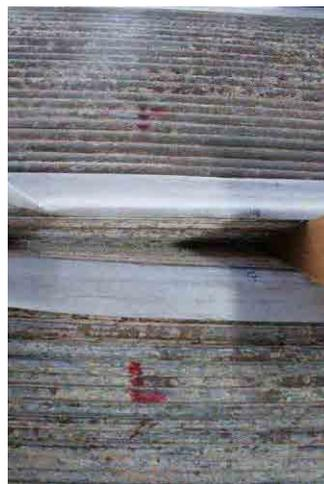
写真 3-42 下流側側面位置での内部。赤さびが内部まで発生している。(G点)
