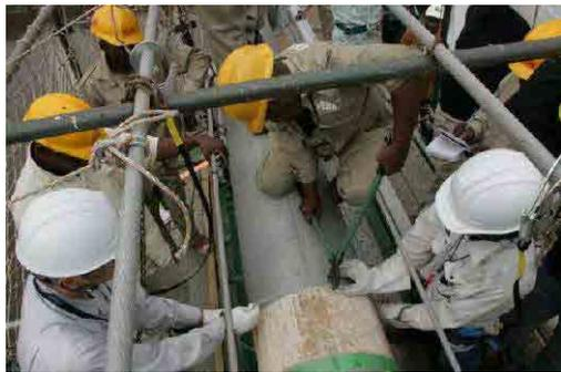
写真 3-15 ラッピングワイヤーの切断撤去
