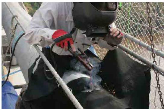
写真 3-51 ワイヤを手で待ち巻きつけていくので作業性の関係で 25cm 程度を一回に巻くことができる。その終点を溶接で止めているところ。
