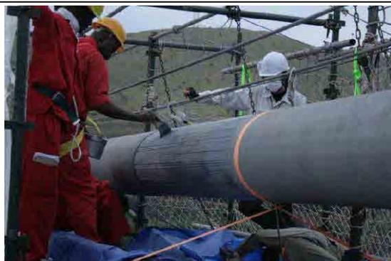
写真 3-48 有機ジンクリッチペイントを施工
