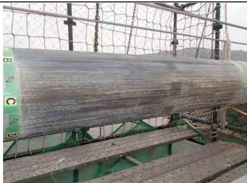
写真 3-61 上流側側面外観、上流側主ケーブルより錆が少ない。
