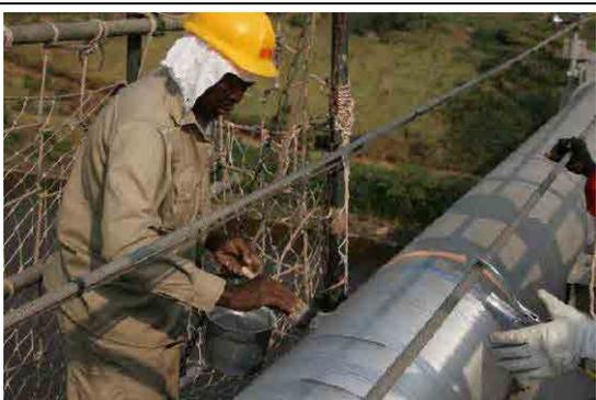
写真 3-55 アルミニウムペイント一層目を 21 日に施工
