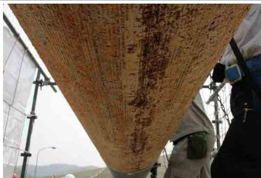
写真 3-22 主ケーブル下側のペーストの状況、赤錆が見えるがペースト除去後も同じ位置に錆がある。ペーストの状況はほぼ素線の状況と対応しているようである。
