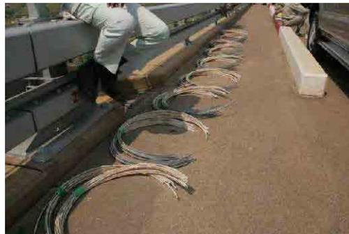
写真 3-18 撤去されたラッピングワイヤー
