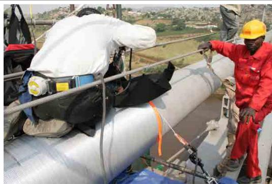
写真 3-52 ラッピング最終点を溶接で止めているところ。既存のラッピングワイヤーとも溶接で接続する。
