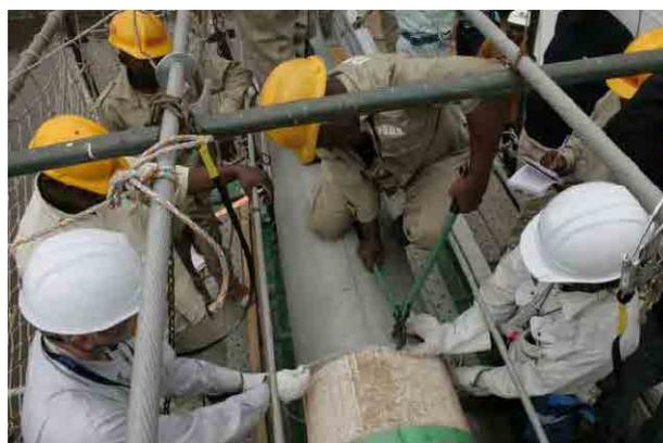
写真-5 ラッピングワイヤの撤去
