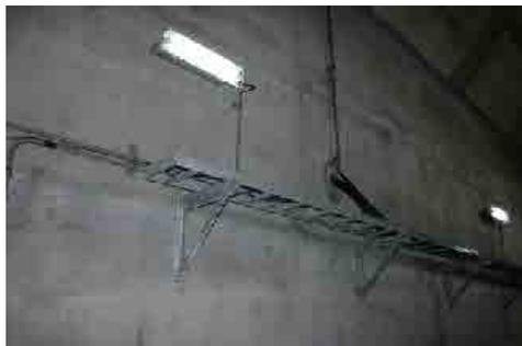
写真 3-92 アンカレイジ内鉄道空間への電力ケーブル配置
