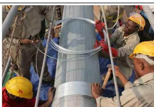
写真 3-50 手でワイヤを主ケーブルに巻きつけていく。
