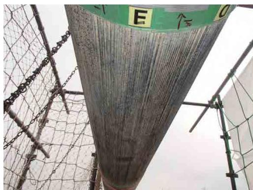
写真 3-60 主ケーブル下面外観、上流側主ケーブルより少し状態は良い。
