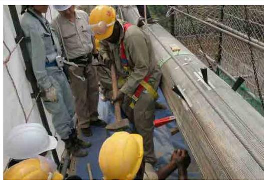
写真 3-36 OEBK 所有の大型ハンマーによるくさび打ち込み作業
