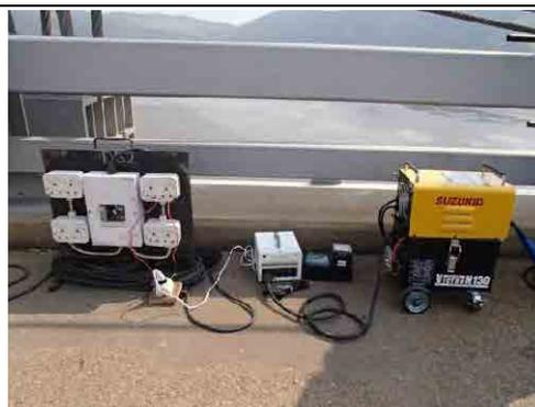
写真 3-58 照明柱からの電源に蓄電池式溶接機の蓄電池をつないだ状態。この状態で溶接を行ったため、電池がなくなる心配はなかった。
