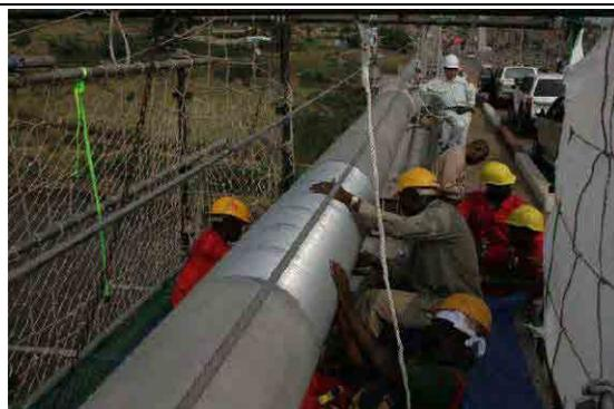
写真 3-54 ラッピング後、表面処理(サンドペーパーによる目荒らし)を行っているところ。ラッピングワイヤーの溶接部分が見える。
