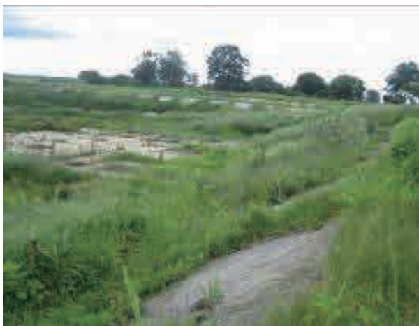
35. ゼンゲザ下水処理場（旧） - 酸化池
