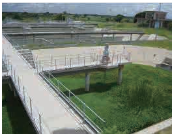
30. ゼンゲザ下水処理場 - 反応タンク（嫌気）
