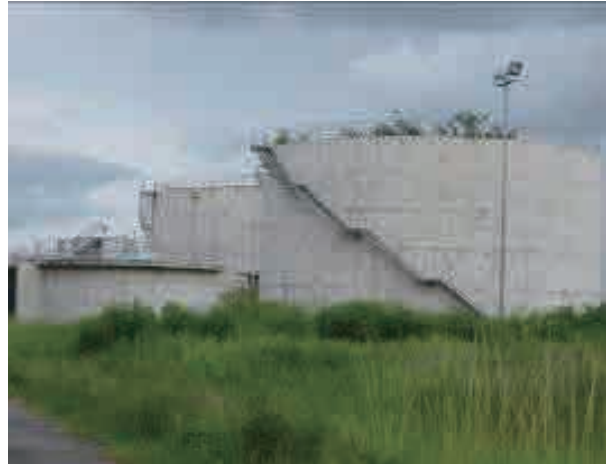
32. ゼンゲザ下水処理場 - 汚泥硝化タンク
