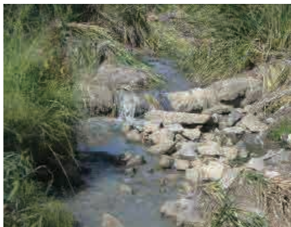
26. 下水管路破損による汚水の流出
