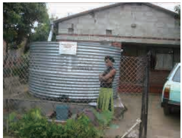
18. 民家の敷地内の雨水貯留タンク
