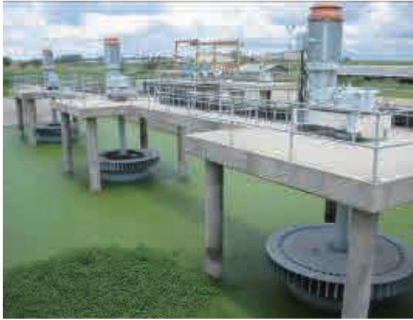
31. ゼンゲザ下水処理場 - 反応タンク（好気）
