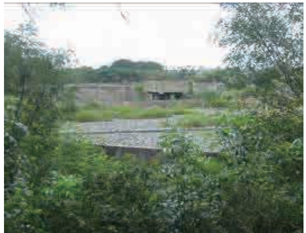
34. ゼンゲザ下水処理場（旧） - フィルター・タンク
