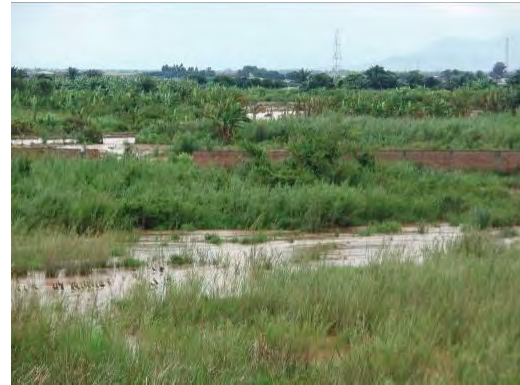
Le Delta de la rivière Ntchangwa lors de l'inondation de 2009. Les murs brisés apparaissent au milieu de la photo. La rivière Ntchangwa se trouve au delà de ce mur. À l'intérieur du mur se trouve une propriété à la sortie du port.
