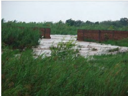
Le cours de la rivière Ntchangwa lors de l'inondation de 2009 a brisé plusieurs murs de brique du port de Bujumbura.
