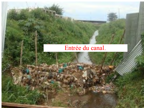
Photo 11.1 : Canal à l'extérieur de la clôture du port
