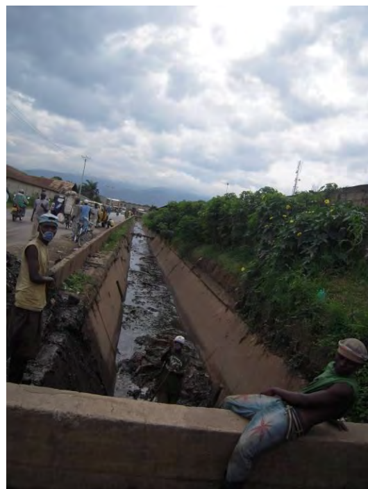
Travaux de nettoyage du Canal de Buyenzi (Photo prise en mars 2012).
