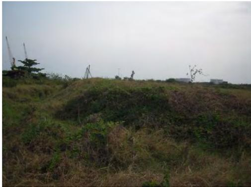
Digue du site d'élimination des boues (Sa hauteur est d'environ 1 m). Pas de couverture ni de mesure pour empêcher la dispersion de la poussière n'existe.
