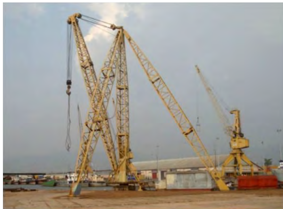
Photo 3.6 : Grue à pylône au port de Bujumbura
