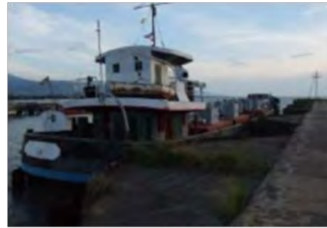
Photo 3.8 : Point d'amarrage du poste pétrolier
