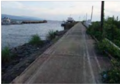
Photo 3.7 : Vue globale de la jetée pétrolière (côté revêtement d'armure de roche)
