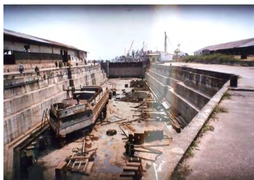
Photo 3.25 : Cale sèche du port de Kalemie
