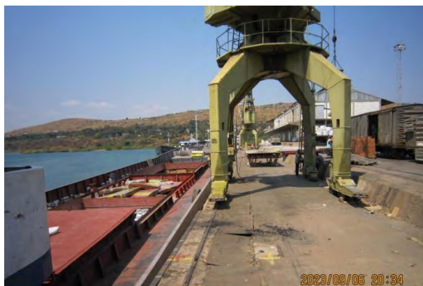
Photo 3.17 : Quai de marchandise générale du port de Kigoma (le bord de l'eau est 85 cm au-dessous du côté terrain)
