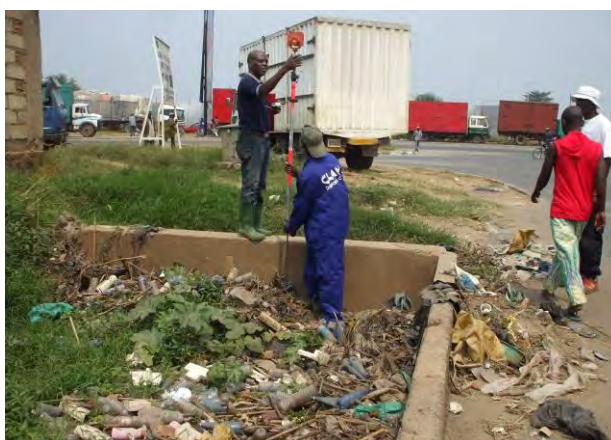
Photo 3.3 : Dépôt de poussière du canal de Buyenzi sur la chaussée adjacente (3 m environ)
