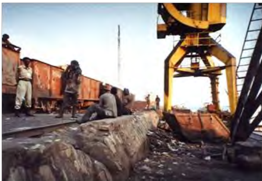
Photo 3.20 : Quai à double élévation du port de Kalemie
