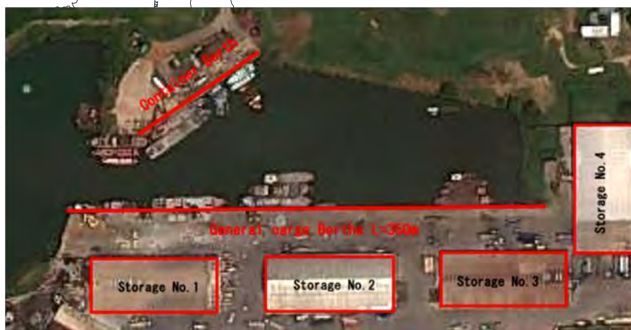
Figure 3.7 : Installations principales du port de Bujumbura
