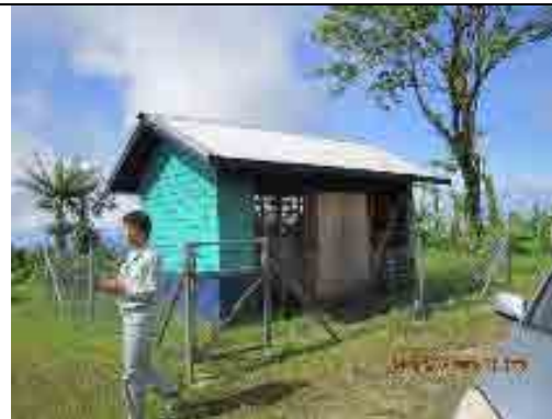
ディーゼル発電機建屋
