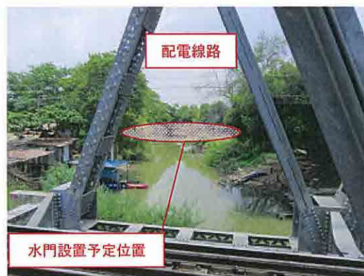
クラマン水門付近
