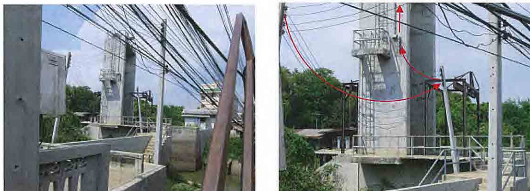
図-2.16 既設水門2(アユタヤ市内)
