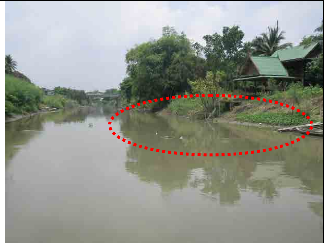
下流側から上流側を見たハントラ水路護岸(左岸側)建設予定地。波形コンクリート矢板(コーピング天端標高+2.5m MSL)背面は、管理用道路(コンクリート舗装 有効幅 3m、路面標高+4.5m MSL)を整備する。
