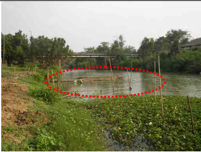
ハントラ水路下流側から見た水門及び護岸建設予定地。水門3門(HWL+6.0m MSL)を既存道路橋の手前に設置する。 水門の下流側は、兩岸をパスツク川に向けて波形コンクリート矢板を用いて護岸整備する。
