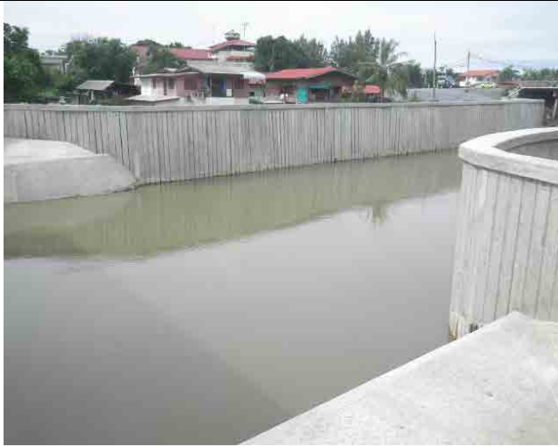
タイ国側で行われた緊急洪水対策工事完了状況。 カマオ水門上流側(既存道路橋まで)に防水壁設置(天端高+6.5m MSL)完了。
