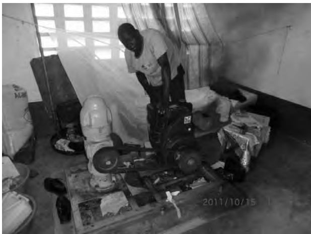
管路給水施設の管理人はポンプ室で寝泊まりしている。エンジン動くがポンプが回らない。(アウエレ RGC)
