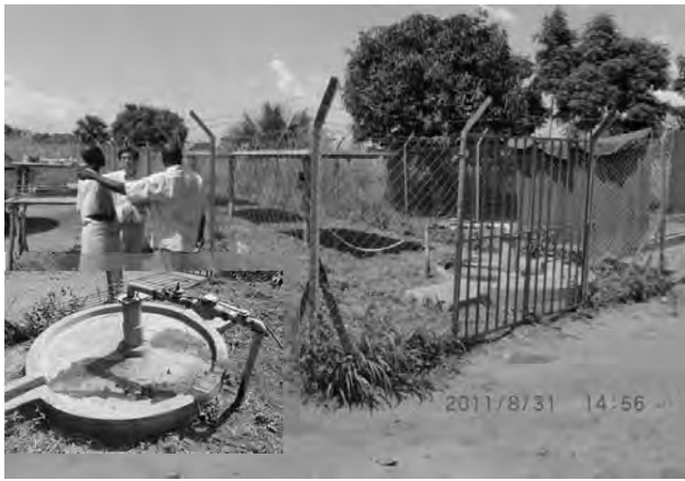
ハンドポンプから転用して建設されたソーラー式管路給水施設。(キトゥグムマティディ RGC)
