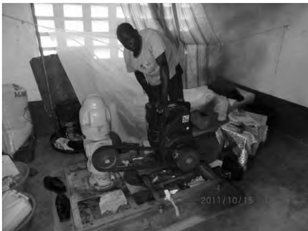
管路給水施設の管理人はポンプ室で寝泊まりしている。エンジンは動くがポンプが回らない。(アウェレ RGC)
