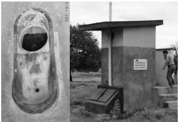
エコサントイレ-大小便を分離(アガゴ RGC)
