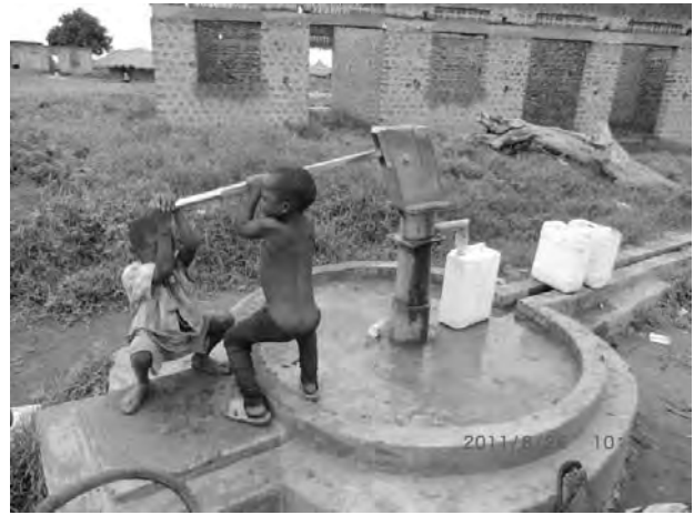
既存ハンドポンプ井戸-揚水量が少なく地下水位が低いため子供にはポンプが重すぎる。(コチゴマ RGC)
