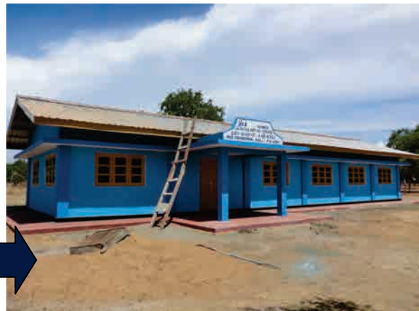
コミュニティ・コントラクトによって復旧さ れた後の多目的ホール (パーリアール村)
