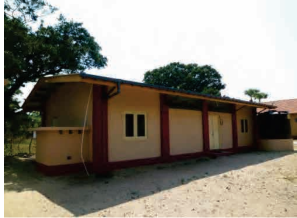
コミュニティセンターの敷地内に復旧された ベーカリー (イルツパイカダワイ村)
