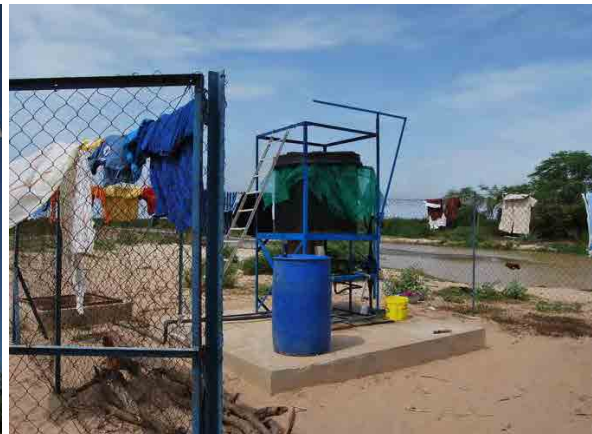
NGO “Aqua Sur” による浄水装置： 給水タンク容量は約 1 ton
