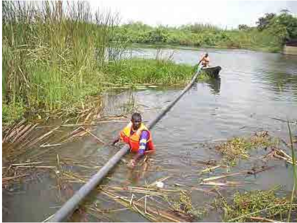
パイロット事業の取水パイプ設置工事
