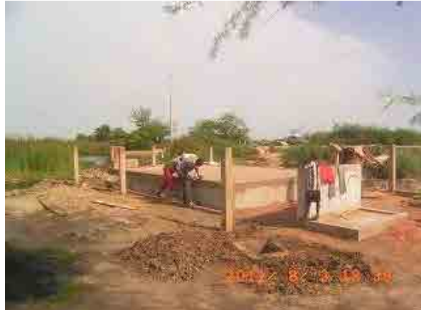
パイロット事業 浄水装置設置サイトの基礎工事
