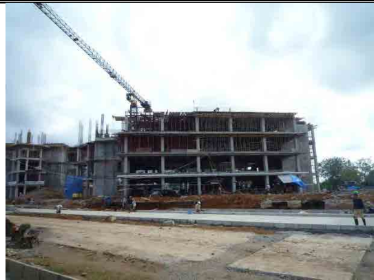
新工学部建設中キャンパス① (ゴア県)
