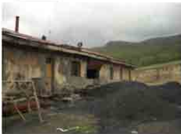
ボイラハウス
