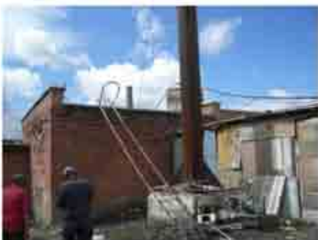
ボイラハウス
