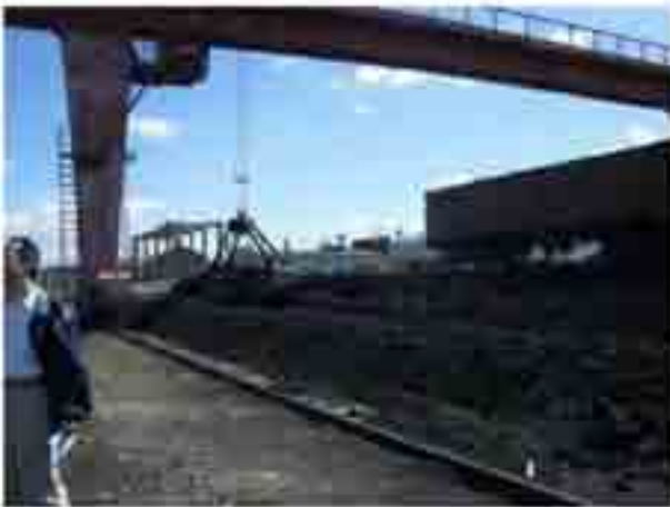
貯炭場 (クレーン)
