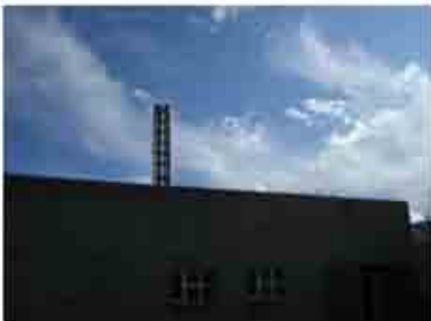
ボイラハウス
