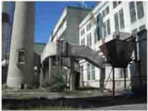
旧煙突 (EP の設置スペース)
