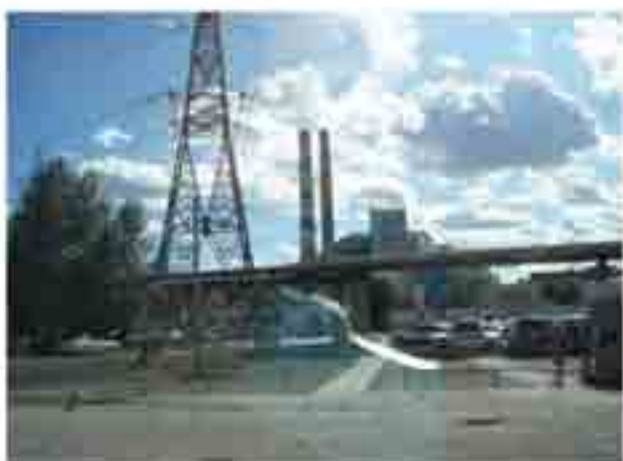
第3発電所全景
