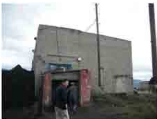
ボイラハウス
