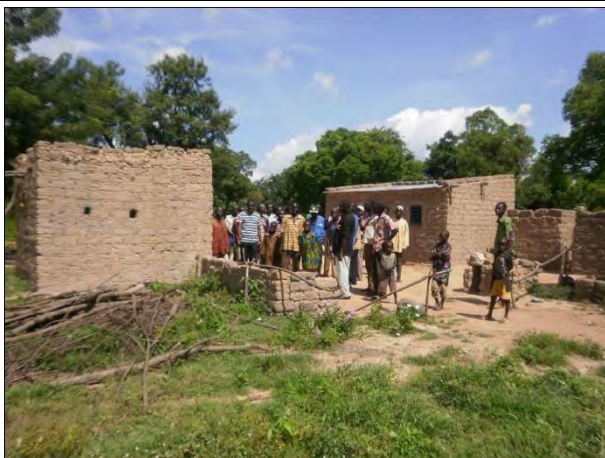
ウエ県ペニ (ダボクライ小学校) 教員宿舎。村民による建設。左より、学校給食にも使われる台所、住居、便所。校長がサイトに居住する必要がある。
