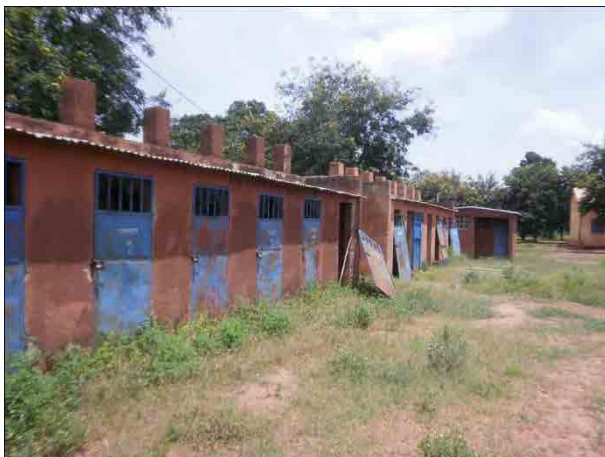
ウエ県ボボ・デウラッソ (キャンプ・ミリタリー小学校) 2 既存校があり、分離校が要請された。
