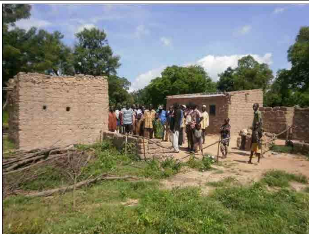
ウエ県ペニ (ダボクライ小学校) 教員宿舎。村民による建設。左より、学校給食にも使われる台所、住居、便所。校長がサイトに居住する必要がある。
