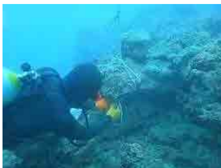
図 5.2.2-2(1) 流向流速計の設置作業状況
