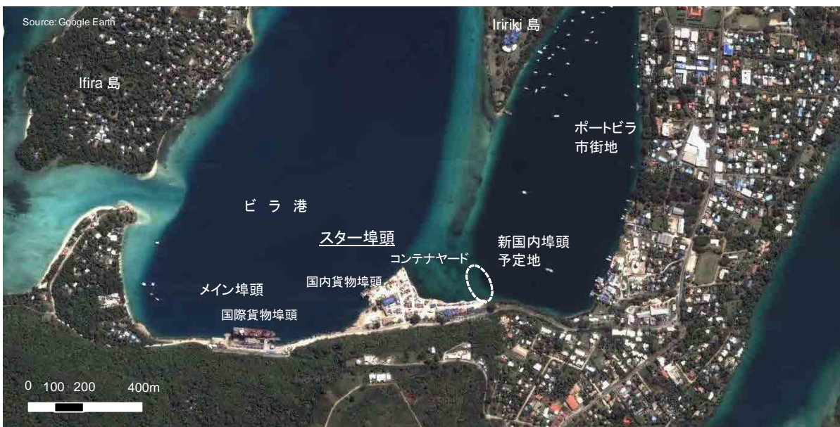
写 1.2-1 ポートビラ港の航空写真
