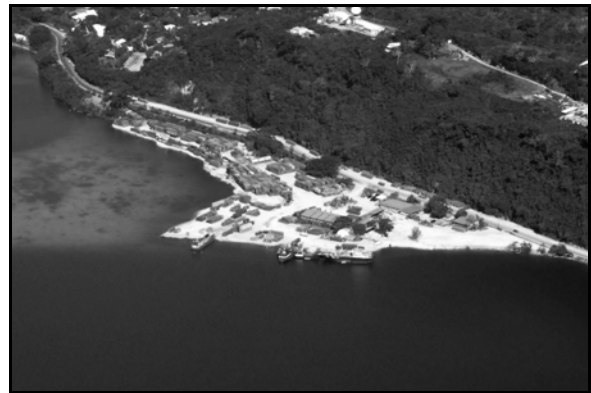
写 1.2-7 2009 年ころのコンテナヤードの状況
