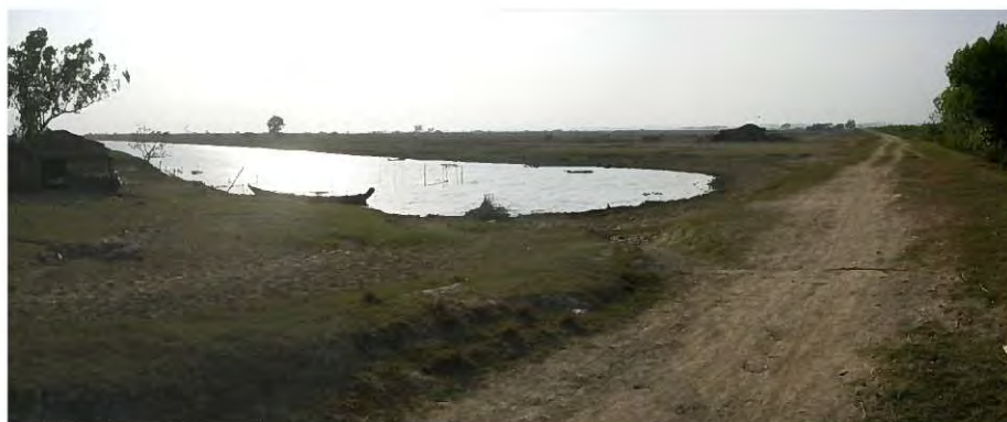
写真-3-2-4 Danechaung 水門近くの支流河川締切り箇所
