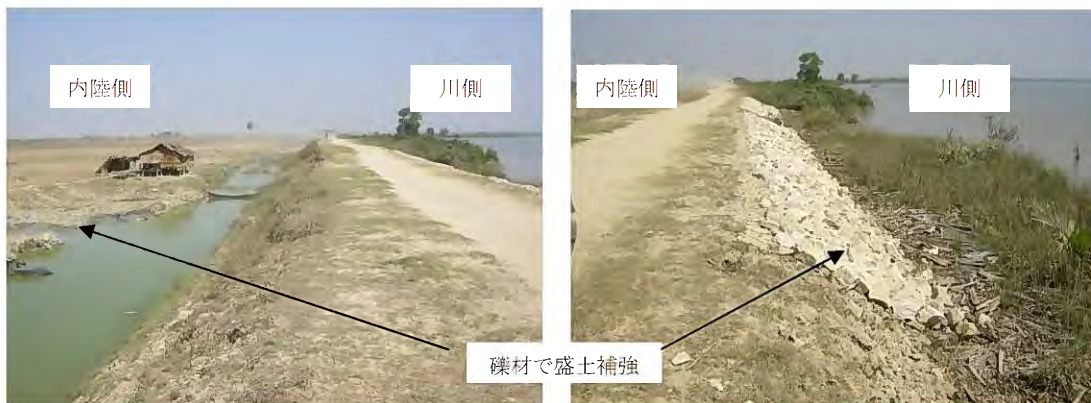
写真-3-2-11 礫材による盛土補強
