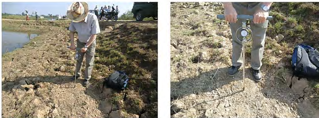
写真-3-2-1 コーン貫入試験状況
