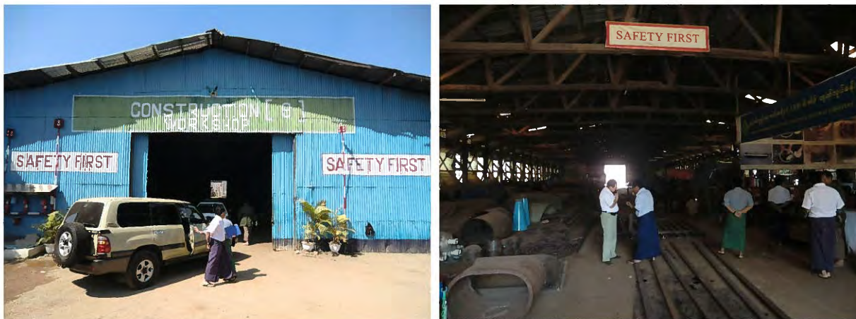
写真-3-2-4 第9建設部 作業場 兼 スペアパーツ倉庫
