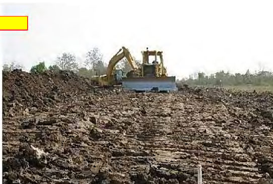
ブルドーザーによる撤出し、転圧状況 (バックホーとブルドーザーのペアで作業している)
