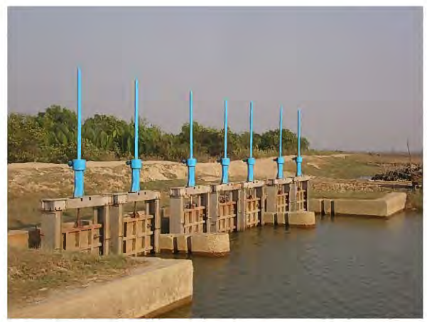
写真 16 : 輪中堤水門 (Labutta South) (2012/03/27)
