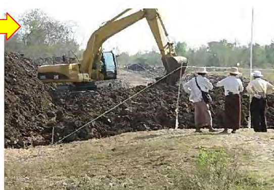
仮置き土 (バックホーの左側) を既設堤防上へ積卸している状況 (手前のテープは堤防の仕上り形状を示す)
