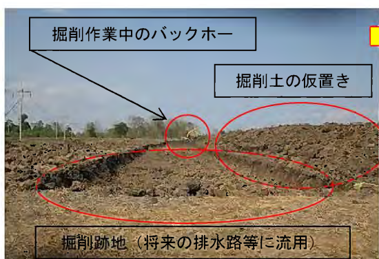
土取場掘削 (掘削幅約 10m、掘削深約 1.2m) 完了後の状況
