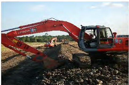
バックホーによる盛土法面仕上げの状況 (堤防の天端からバケットをかき上げて整形を行っている)
