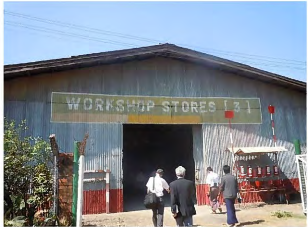
写真 4 : 第 1 機械部スペアパーツ倉庫 in Yangon (2012/01/16)
