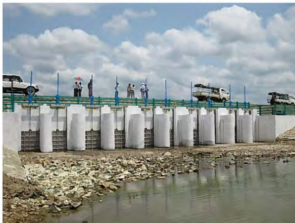
【復旧工事後の状況（実証事業）】
