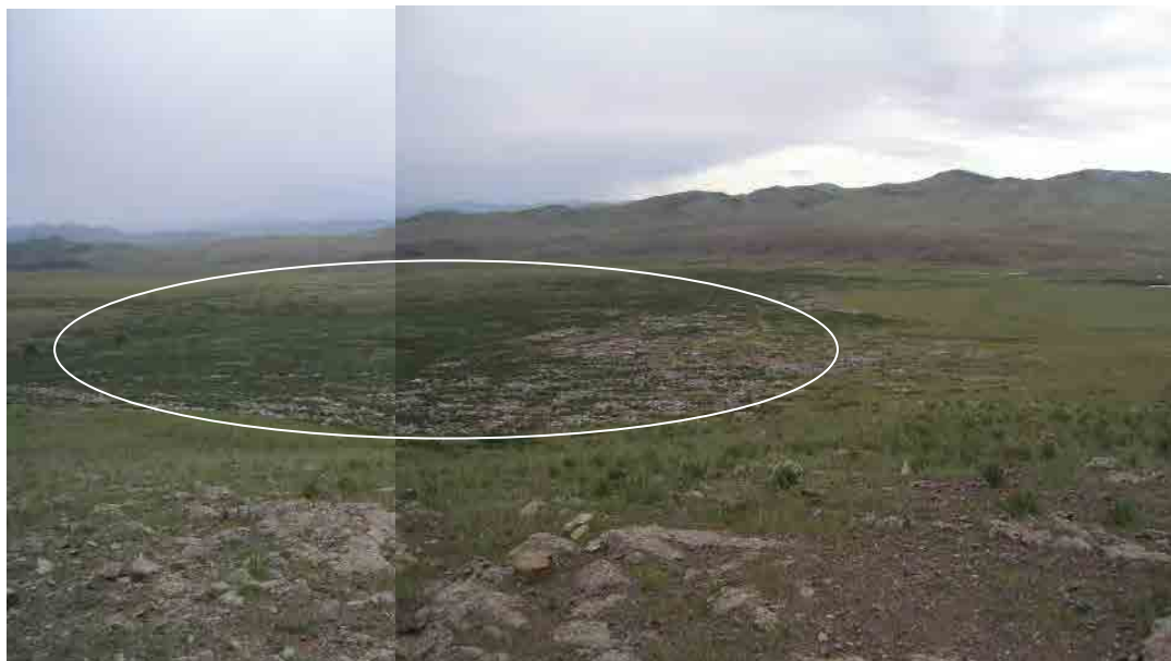
図 G.3: 東側斜面からみた処分場全景
