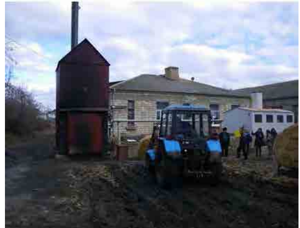
小学校設置ボイラー （Hirtopul Mare村）
