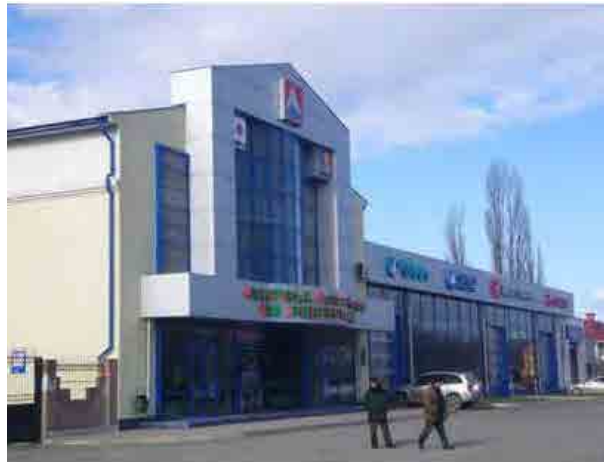
本部メンテナンス工場兼宿泊・食堂
