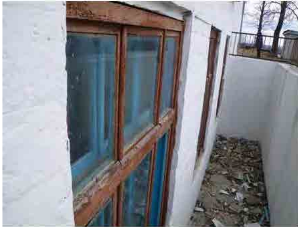
通常の窓ガラス（二重窓にはなっている） （Hirtopul Mare村）
