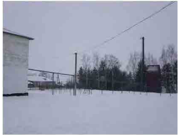
小学校ーボイラー間の配管 (Burlanesti村)
