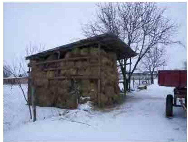
ボイラー隣接の2次保管施設 (Taraclia村)
