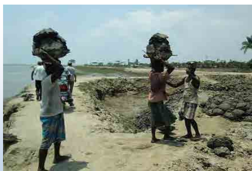
「Cash for Work」でポルダー修復する住民② (堤防の嵩上)
