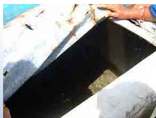
雨水の貯水用のタンク (カバーをかけ埃やゴミが入らないように配慮されて)
