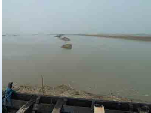
サイクロン「アイラ」により破堤したポルダー
