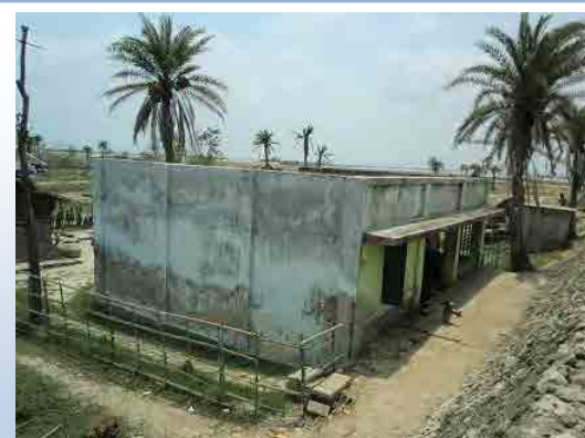
サイクロン「アイラ」襲来時に住民の避難先 となったコンクリート製の建物
