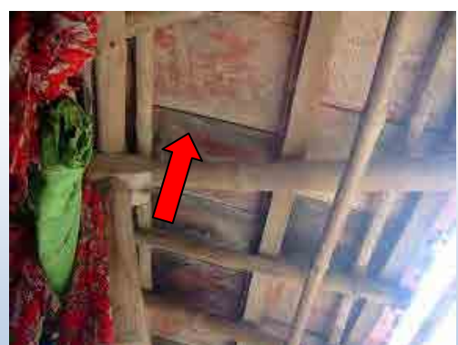
家が風で飛ばないように屋根にレンガをのせている
