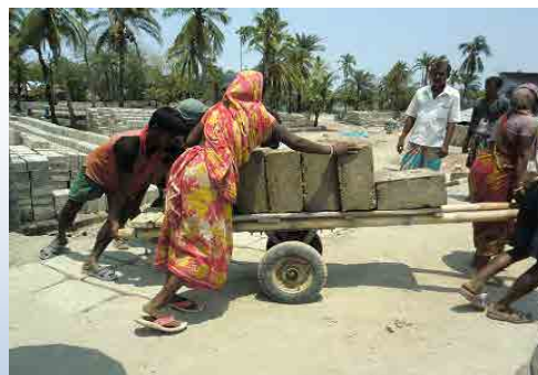
「Cash for Work」でポルダー修復する住民① (土木工事には女性も多数従事している)
