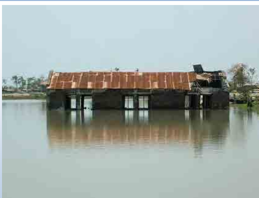
サイクロン「アイラ」による高潮で浸水し 現在も水に沈んでいる学校
