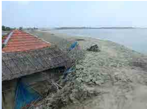
ポルダーに内側すぐの場所にある家屋 (高潮ですぐに浸水する危険性が高い)
