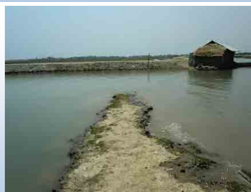
サイクロン「アイラ」の高潮による浸水で沈んだ道
