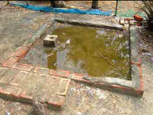
サイクロン「アイラ」で破壊されたある小学校の水道設備（パイプラインによる配水、水源は不明）
