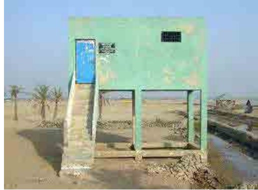
ドイツ支援による高床式の種子の貯蔵庫（アイラで種子が流されるのを防ぐことはできたとのこと）
