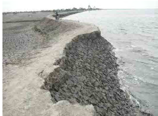
河岸侵食で堤体欠損が進む堤防（幅 4.27m 天端は殆どが欠損流出している）
