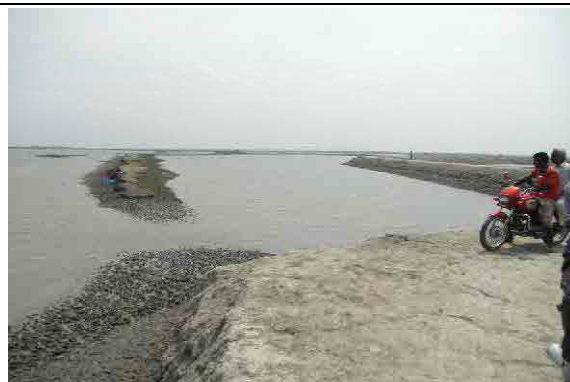
「アイラ」来襲時に全壊した堤防（左）と新たに建設した切り回し堤防（右）
