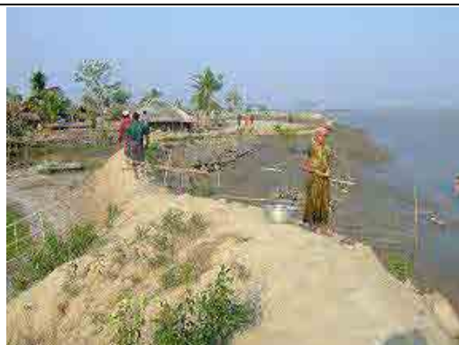
緊急修復後に崩れてしまい幅の狭くなった堤防 (堤防は生活道としても利用されている)
