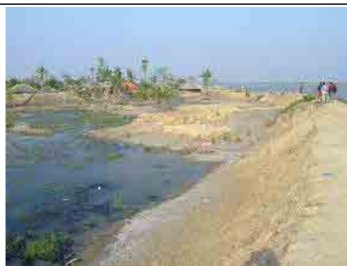
「アイラ」以降、堤内地に溜まったままの水
