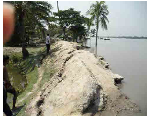
河岸侵食により欠損が進む堤防兼域内道路
