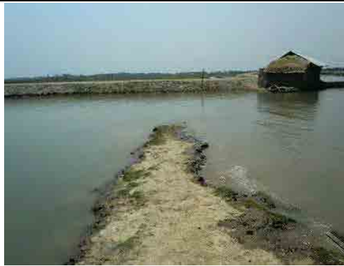
「アイラ」の高潮による浸水で沈んだ道
