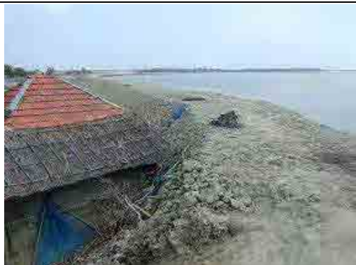
堤防に接した堤内地側の家屋 （高潮ですぐに浸水する危険性が高い）
