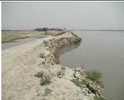
河岸侵食によるスベリ破壊に伴い欠損した堤防
