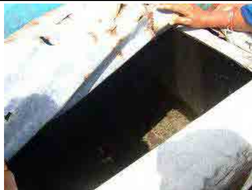
雨水の貯水用のタンク（カバーをかけた埃やゴミが入らないように配慮されている）
