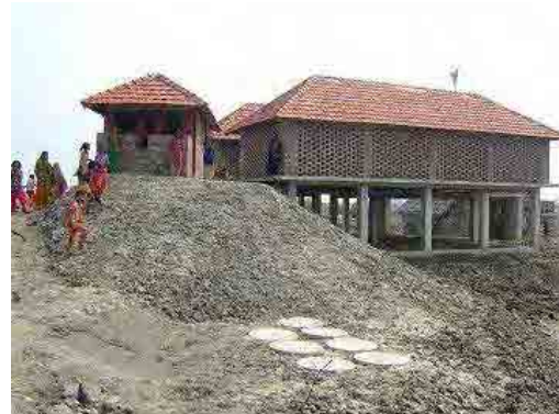
UNDP の支援による高床式学校（床下に雨水貯めている）
