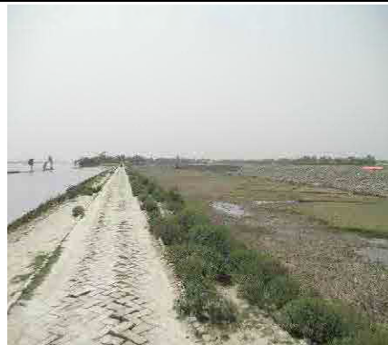
河岸侵食区間の新旧堤防 (左は旧堤防、中央は現堤防、 右は新切り直し堤防)
