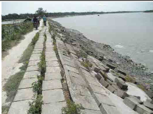
河岸侵食により破壊されたCCブロック護岸工と散乱する無連結ブロック
