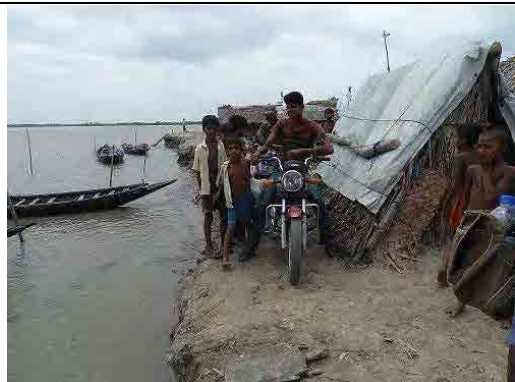
被災後に堤防上に設けられた簡易住居（堤防が崩れかかっている）
