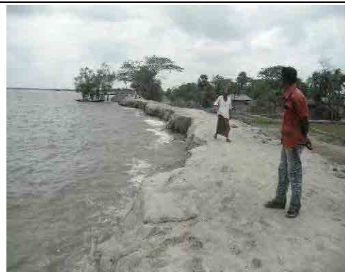
サイクロン「アイラ」被災後に建設された復旧堤防であるが波浪侵食により既に欠損が進行している
