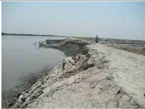
河岸侵食に伴うスベリ破壊により欠損が進む堤防
