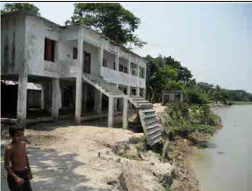
河岸侵食により階段基礎が流出した学校兼シェルター
