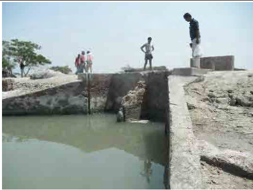
劣化が激しくコンクリート門柱が欠損した樋門
