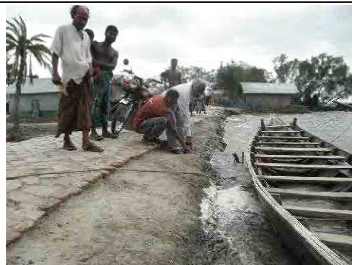
沈下のため高水位時に越流リスクが有る堤防（人が指差ししているレベルは、通常の満潮位を示す）
