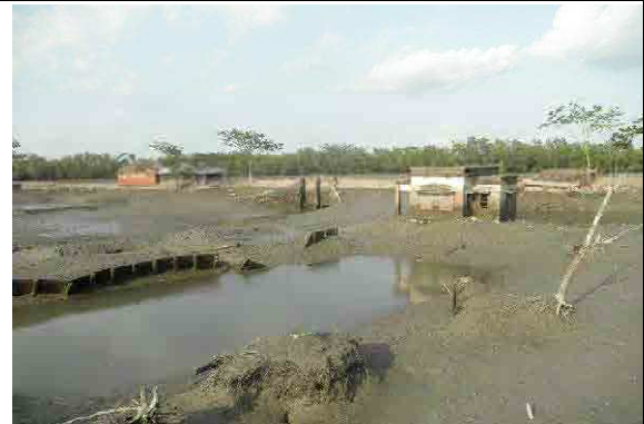
門扉が破壊された樋門（中央）と切り回し堤防の建設で放棄された堤内地
