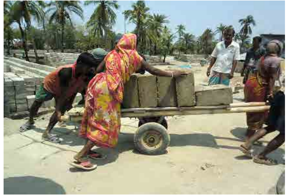
「Cash for Work」でポルダー修復する住民（土木工事には女性も多数従事している）
