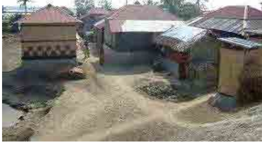
堤防上から見た村の様子
