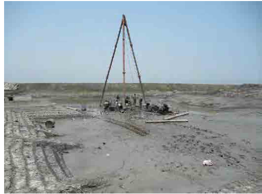
樋門の現場打ち RC 基礎杭の打設現場（建設機械は巻き上げウインチのみ）
