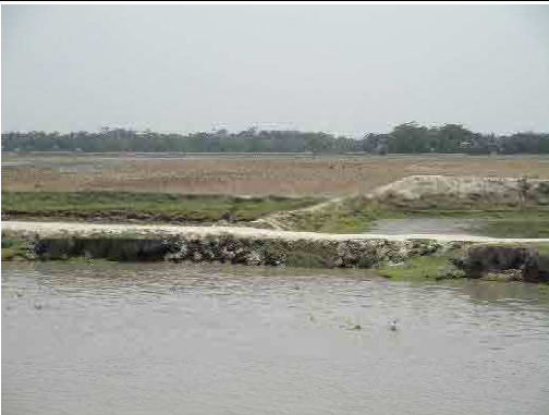
住民が建設した小規模堤防、通常満潮位でも余裕高は僅かしかない
