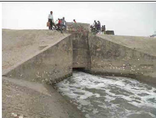
堤内側のゲート扉体が全壊し、堤外側フラップゲートだけで水流制御する樋門
