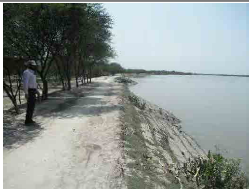
河岸侵食に伴うスベリ破壊で破壊が進む CC ブロック護岸工
