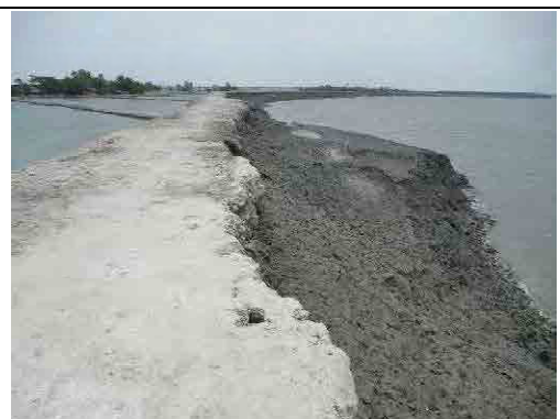
河川蛇行凹部区間の河岸侵食と欠損が進む堤体
