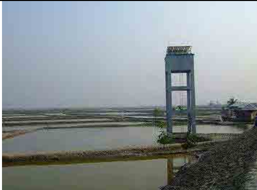
「アイラ」襲来後の NGO（名称不詳）支援による高架水槽。（上部にソーラーパネル設置 3km ほどのパイプラインが敷設されている）
