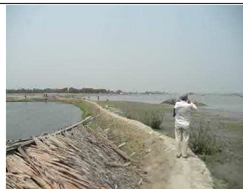
サイクロン「アイラ」被災後に建設した応急仮堤防（中央）と破壊された樋門の残骸（右側）
