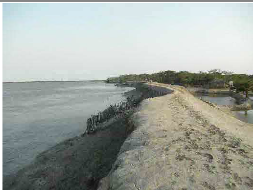
スベリ破壊を伴う河岸侵食区間の堤防欠損と竹柵による侵食防止工
