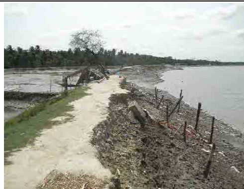
河岸侵食により全壊した堤防（上下流には、仮設サンドバッグが散乱）
