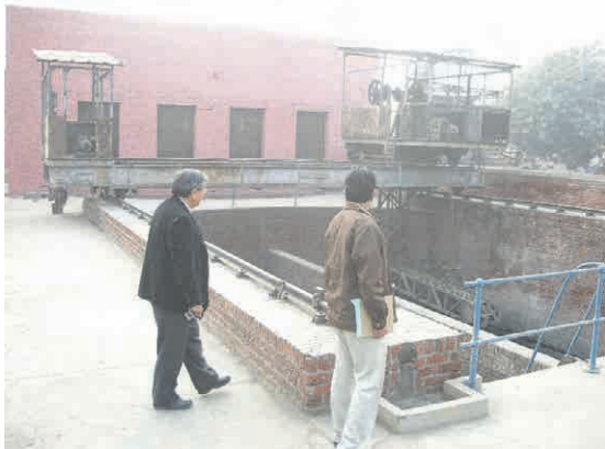
Main Outfall ポンプ場の沈砂池 機械設備の老朽化が進んでいる。
