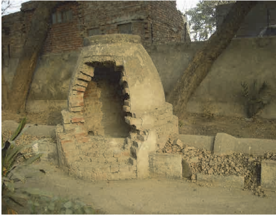
WASA 研修センターのマンホール・下水管 (地上に設置し、教材として利用)
