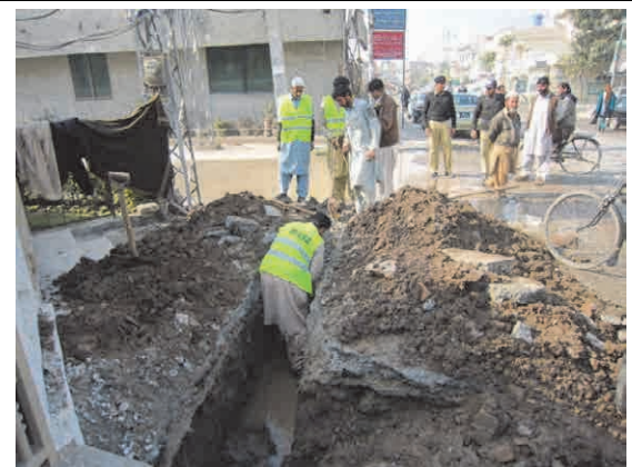
漏水管の補修現場 (黄色の上着を羽織って、 交通安全の対策をとっている)
