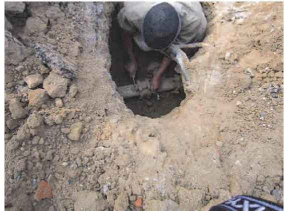
漏水管の補修 (給水されていない時間帯に ギボルトジョイントを使って補修をしている)
