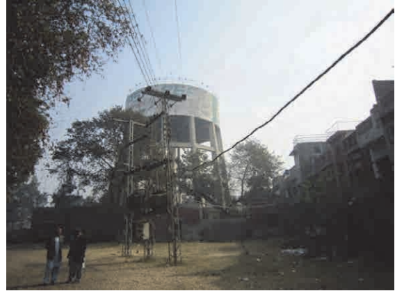
市内の高架タンク (夜間の水圧が高いときのみ貯水される。 昼間は井戸ポンプ場から直接配水)
