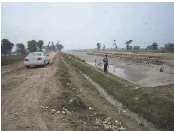
JICA無資金協力で伏流水を水源とした井戸 （25本）が建設される予定のジャン用水路
