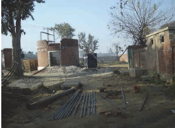
改築中のポンプ場 モーター室（左）、電気室（右）
