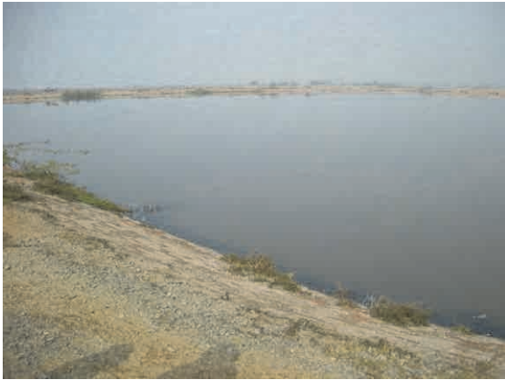
下水処理場の通性池。機械設備を設けず、好気・嫌気状態で、汚水を処理する（滞留時間 25 日）
