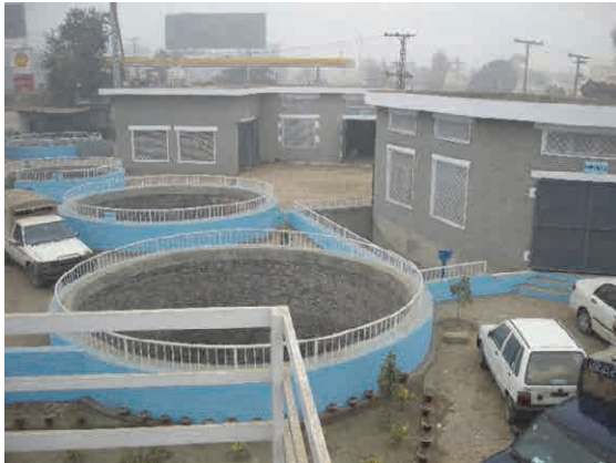
改築増設されたポンプ場 〔2系列（2棟）のポンプ棟で、円形のスクリーンと流入井で構成される〕
