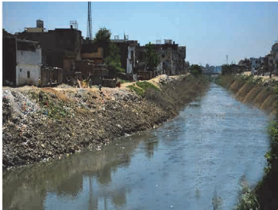
しゅんせつ・河道拡幅による市内河川の改修事業（WASA 提供）
