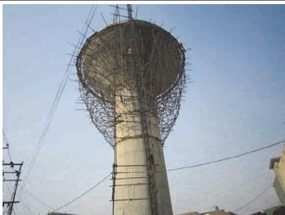
現在建設中の高架タンク
