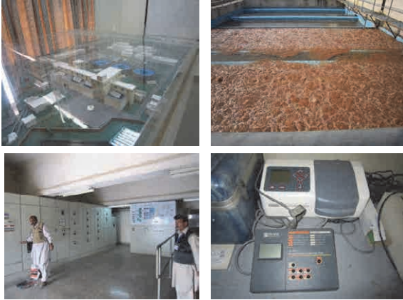
ラウルダム浄水場(左上:浄水場施設配置模型、 右上:急速ろ過池の逆洗風景、左下:コントロ ール室、右下:水質分析室の吸光光度計)
