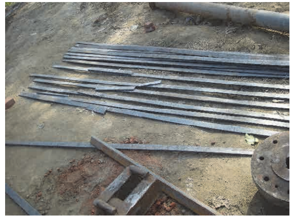
ポンプ場スクリーン設備の補修。オペレーター が鋼材を現場で加工し保守を行う。
