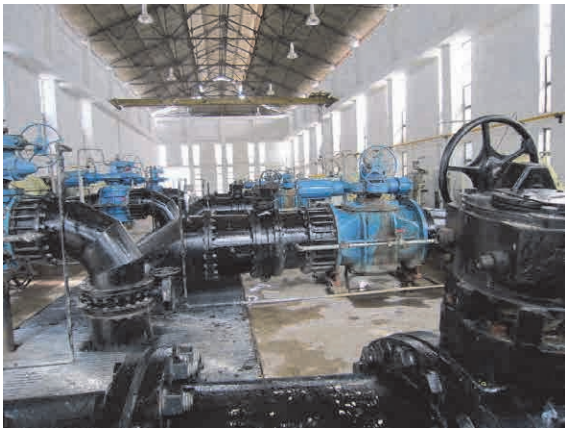
チェナブ川の伏流水を水源とした井戸（29本） の水を市内に送水するポンプ施設（1993年に ADBの融資で建設、水需要の90%を供給）
