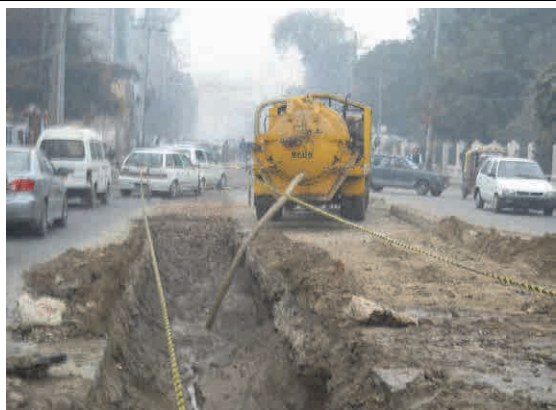
汚泥吸引車を使った工事現場の排水作業
