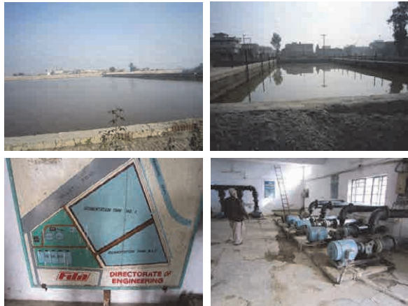
市内にある古い浄水場（水需要の10%を供給） 左上：普通沈殿池、右上：緩速ろ過池、左下： 浄水場施設配置図、左下：配水ポンプ施設
