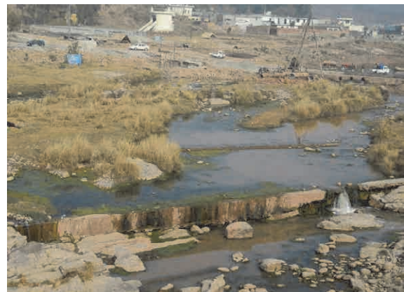
ラワールダムに流入する河川排水の影響を受けて藻類が発生している。
