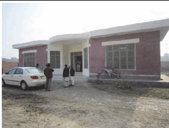
新しく建設された水質試験室
