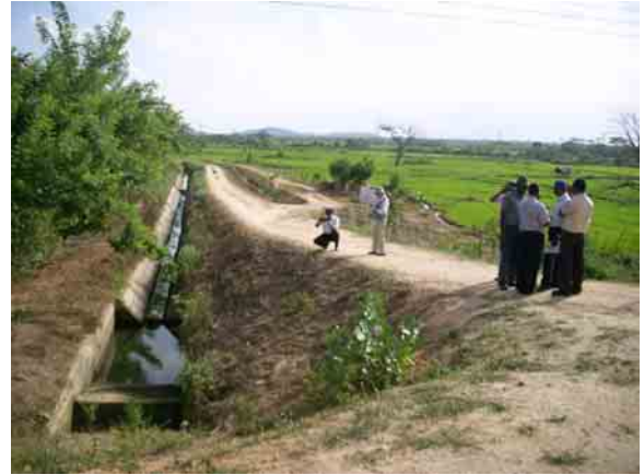
貯水池につながる急傾斜の農道 (next to LT-2, Mayurapura Block)
