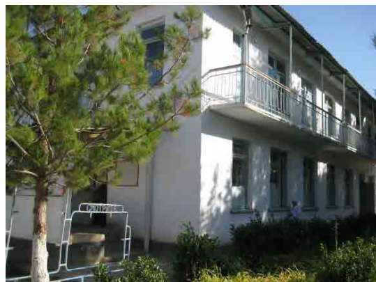
ジョミ郡管区病院（Bahor）外観
