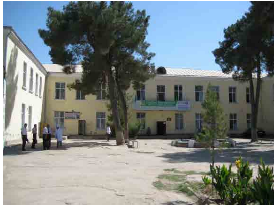
ジョミ郡中央病院外観
