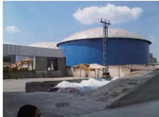
Iniciamos la visita a Vidriera de Toluca S.A. en el área de materias primas, constatando que los componentes fundamentales para fabricar cristales son arena silícica, carbonato de calcio, feldespatos y calizas. Estos materiales se almacena en silos de 1.400 toneladas y la mezcla de estos materiales se lleva a cabo en función del material solicitado, para lo cual deben seguirse normas estrictas de calidad de materiales y de la mezcla, por lo cual la empresa cuenta con proveedores acreditados.
