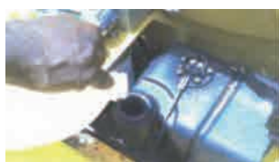
機材稼働時間に対する燃料消費量確認のための給油
