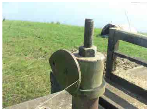
7b. Suchia 排水樋門の巻き上げ機
