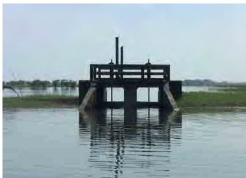
7a. Suchia 排水樋門全景
