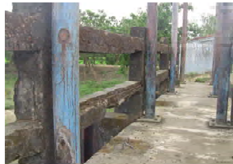
1f. Charervita 樋門操作台手すり
