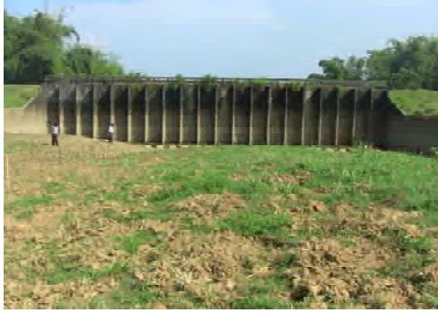
6a. Teli Khal 排水樋門全景
