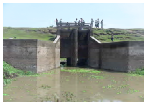
3b. Ganakkhali 2 門樋門
