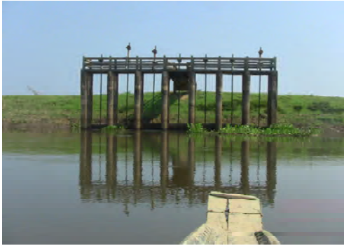
5a. 5号排水樋門全景
