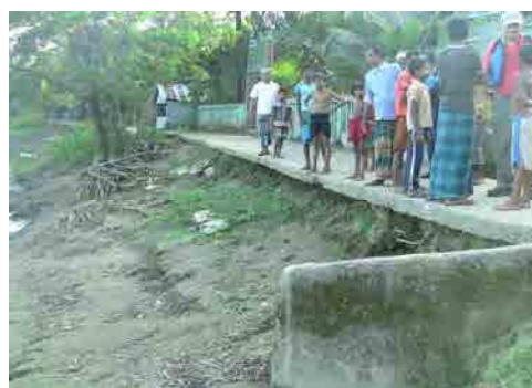
7d. 堤防の現況
