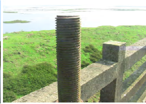
5b. 5号排水樋門の巻き上げ機
