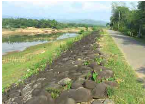
6f. 堤防に設置された空石張り護岸
