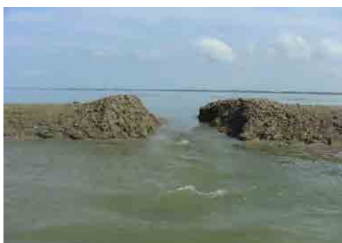
7c. Suchia 排水樋門付近の潜水堤防
