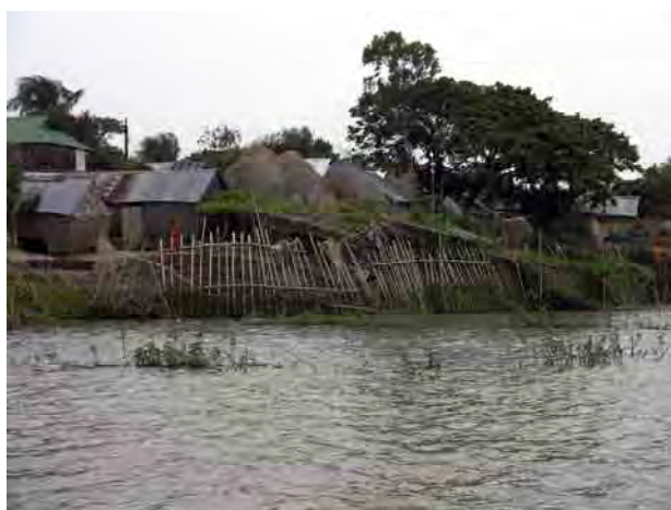
ハオール内居住地を波浪から守るため住民による竹と草による簡易護岸（ネトロコナ県 Khaliajuri）
