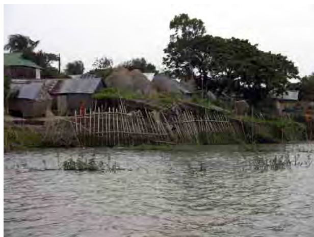
ハオール内居住地を波浪から守るため住民による竹と草による簡易護岸（ネトロコナ県 Khaliajuri）
