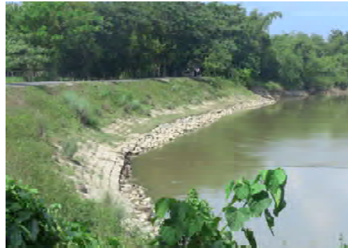
コンクリートブロック護岸工
