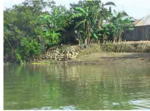
空石張り護岸工
