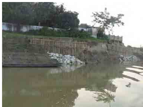
簡易な竹柵水制工
