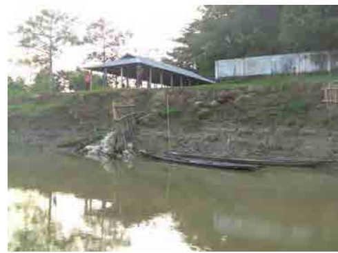
竹柵水制工の背面
