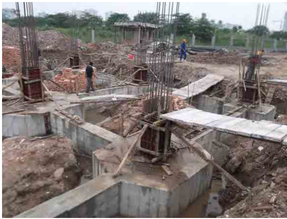
写真 3 : データセンター棟建設現況 (2011 年 10 月 21 日撮影)。基礎工事段階。
