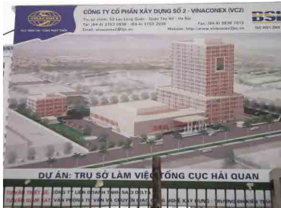
写真 1 : GDVC 新庁舎建設現場標識 (完成予想図)。左奥がデータセンター棟 (5 階建)。
