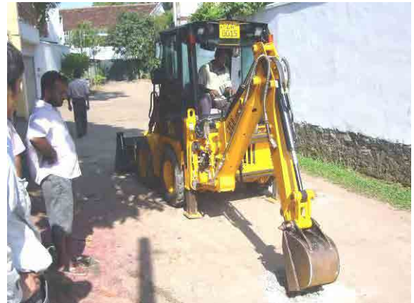
埋設されたバルブ位置の特定作業
