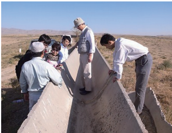
3. フリュームの継ぎ目の補修状況の視察
