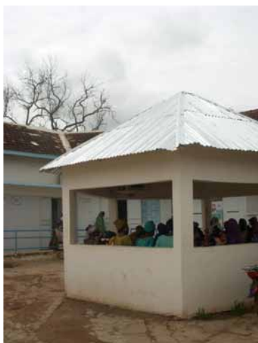
タンバクンダ保健センターでは、プロジェク ト経費により待合小屋を建設。
