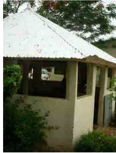
コチャリ保健ポストの保健委員会の予算で建 設した待合小屋。地面もタイルを貼り、雨期 でも歩きやすいよう配慮。
