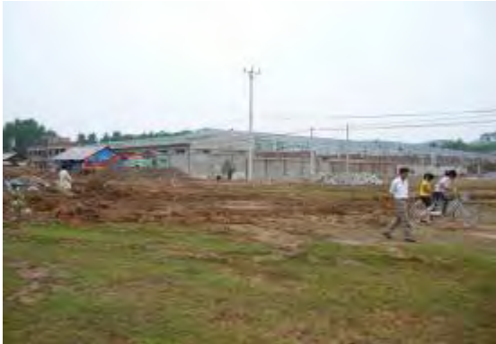
写真 3-27 ロンビンアン工業団地(建設中の韓国系縫製工場)
