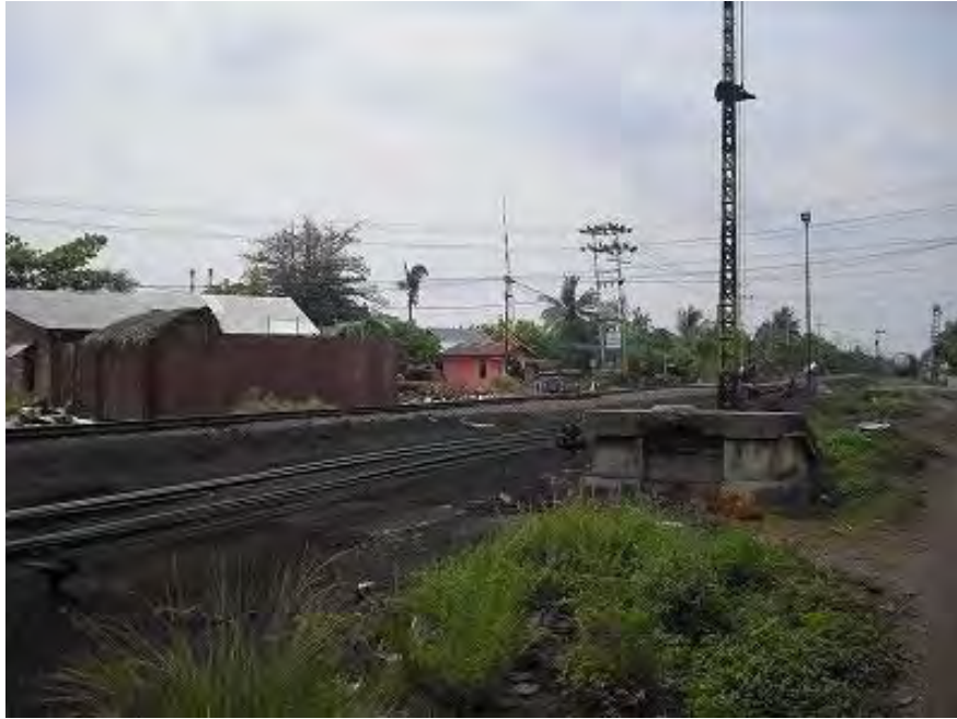
【写真 10-1-3】線路周辺の廃棄物
