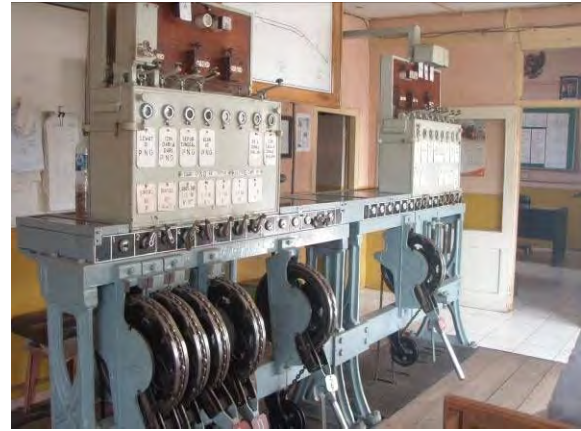
【写真 4-1-8】 プラブムリー信号通信機器室設備とグヌンメガン駅の機械式信号設備
