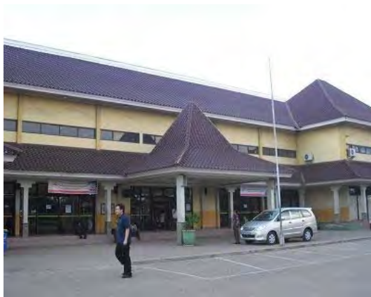
改築中のクレタパティ駅
