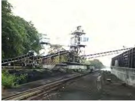
ベルトコンベヤからバージへの積込み風景
