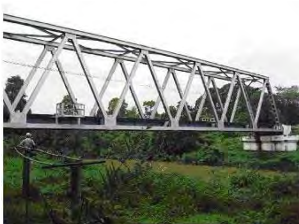
【写真 4-1-4】 367k461m 付近の BH No. 837 トラス橋 (L=50m)
