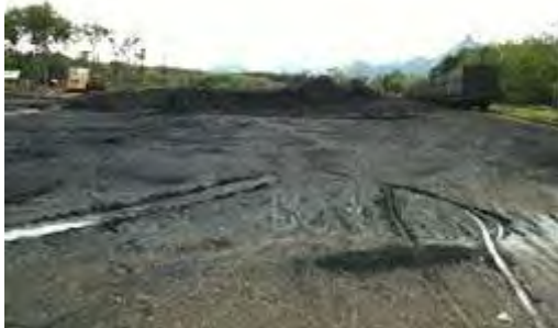
スカチンタ駅構内の石炭ストックヤード
