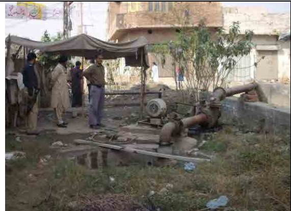
小規模屋外ポンプ場
