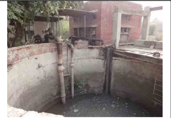
ポンプ場内の受入ピット
