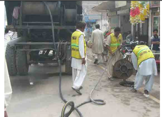
高圧洗浄車による下水管の清掃
