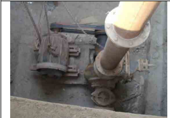
ポンプピット内横型モータ・ベルト駆動式ポンプ
