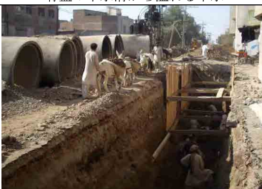
下水管敷設工事
