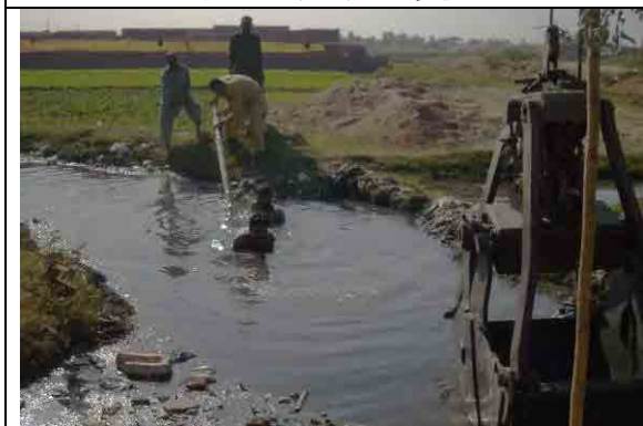
排水路の人力による清掃
