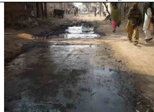
有蓋の下水溝から溢れる下水
