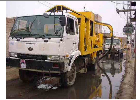
汚泥吸引車による冠水除去
