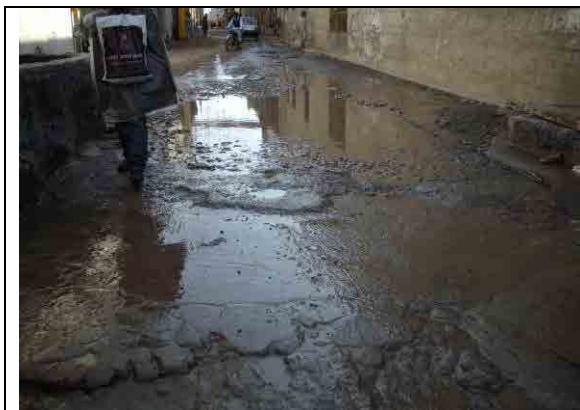
市内道路の冠水状況
