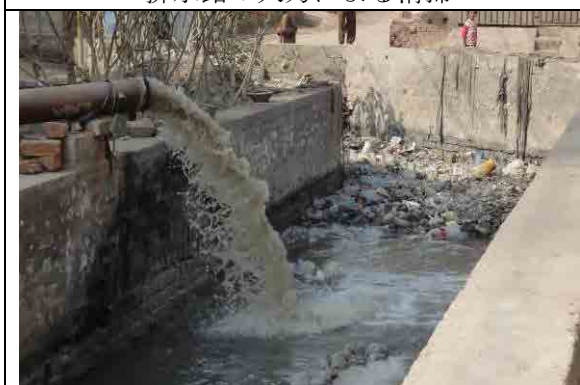
下水溝への排水と堆積するゴミと汚泥
