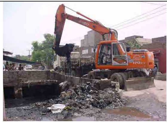
バックホーによるゴミ・汚泥浚渫
