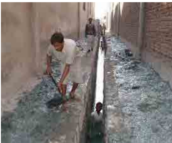
図 3-2 市街地下水溝清掃の現況
