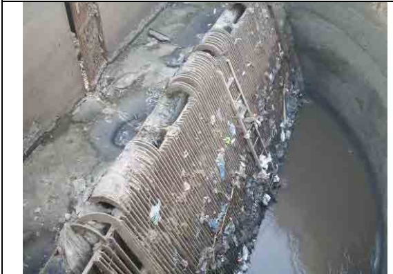
流入槽のグレーチング
