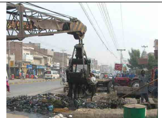
バケット・クレーンによるゴミ・汚泥浚渫
