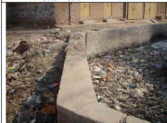
浚渫後排水路付近に放置されたゴミと汚泥
