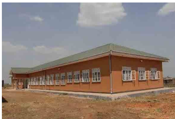
図 2.1.2 パボ・パブリックホール外観
