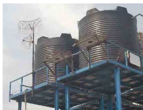
図 2.1.13 無線インターネット設備
