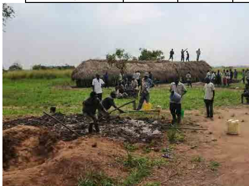
図 2.2.15 共同作業による教室増築
