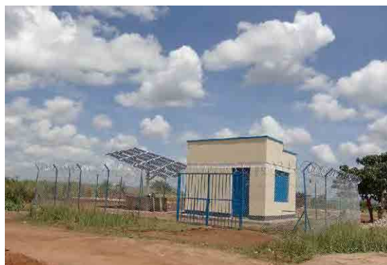
図 2.1.5 パボ・揚水機場外観
