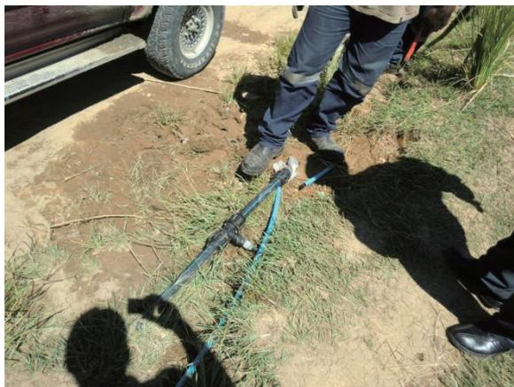
**給水管の再接続作業現場 :**
