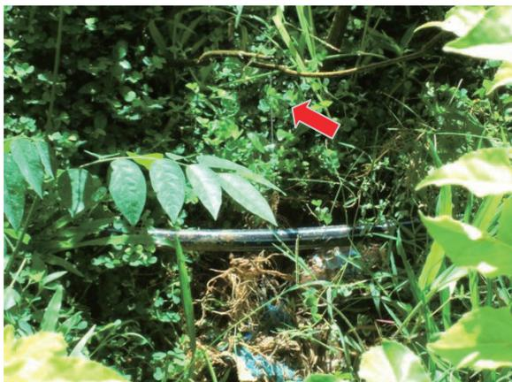
**露出給水管からの漏水：**
