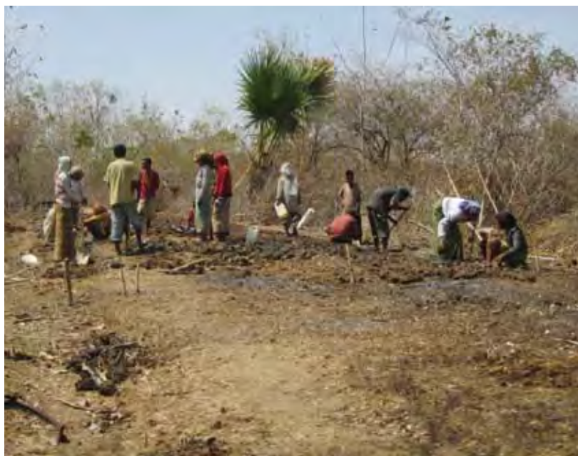
コミュニティ道路を整備する住民(東ティモール) 近隣の道路を整備することで、住民はクリニックや学校、市場などに行きやすくなる。また、住民が工事に参加するため、住民の主体性が育まれ維持管理の効果も高まる
