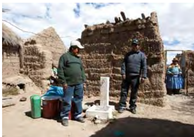
貯水タンクから各家庭に配管された水道(ボリビア：生命の水プロジェクト)
