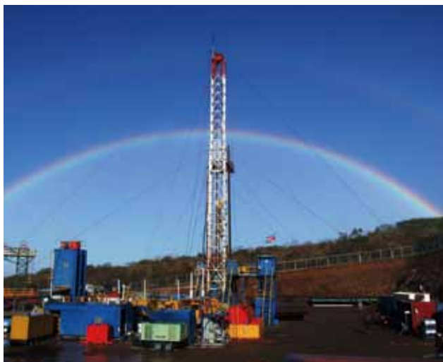
コスタリカ電力公社(ICE)が掘削する地熱井。JICAは「グアナカステ地熱開発事業準備調査」を通じて本井戸の蒸気データ分析等を支援している
