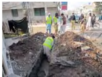
パキスタン・ラホール市漏水管の補修現場
