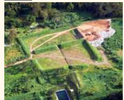
サモア タファイガタ処分場 日本の一般廃棄物処分場の標準構造を開発途上国の状況に合わせてローコストで適用できる「福岡方式」を採用
