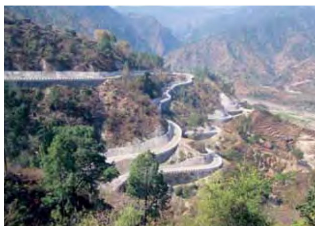
山岳地域の道路建設により国内アクセス強化に貢献
