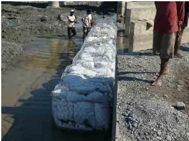
⑤ 取水口前面の布団籠(IRCP II により設置)
