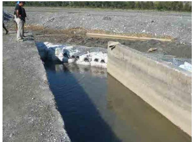
⑥ 布団籠中に設置された取水用塩ビ管(IRCP II により設置)
