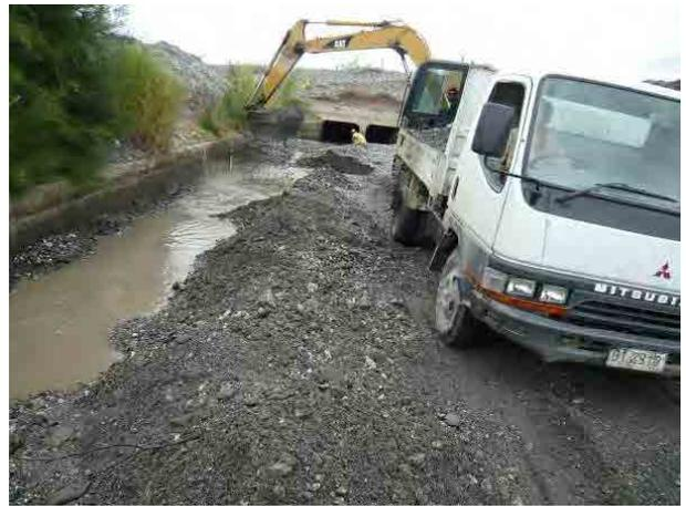
⑭ 沈砂池堆砂の浚渫・運搬 (2007. 8)
