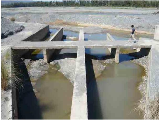
① ラクロ川の取水口(取水口改良工事のため浚渫済み)
