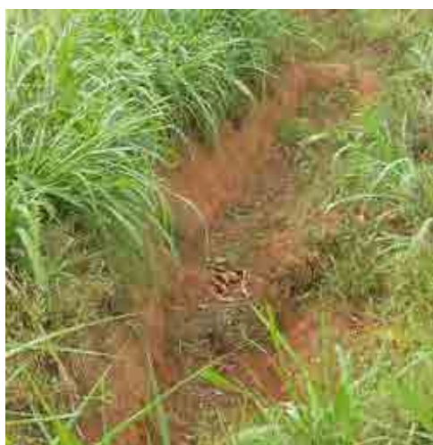
Ouvrage d'interception d'écoulement d'eaux pluviales, réalisé sur la pente de la culée de la rive droite
