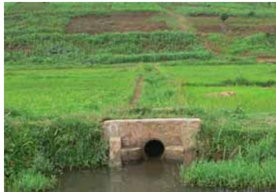
Embouchure d'entrée vers le canal, située directement en amont du barrage déversoir.
