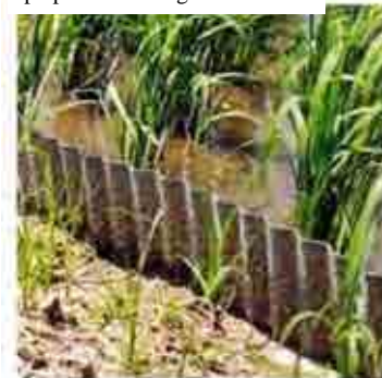
Exemple de fabrication de palplanche de diguette
