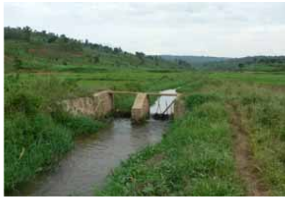
Barrage déversoir située à environ 4 km en avant. Non exploitée.
