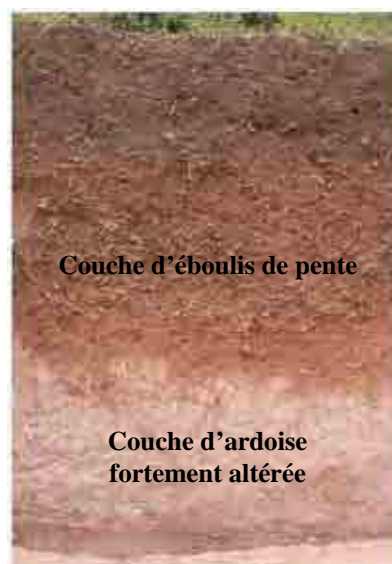
Couche d'éboulis de pente apparaissant sur le plan du déblai de la route rénovée en amont sur la rive gauche
