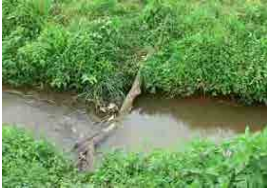
Tronc d'arbre employé comme barrage temporaire pour relever le niveau d'eau à 500 m en aval.
