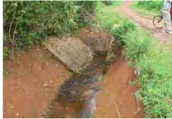
Le canal d'évacuation a son extrémité à 50 m en aval du déversoir et s'écoule jusqu'au cours d'eau.
