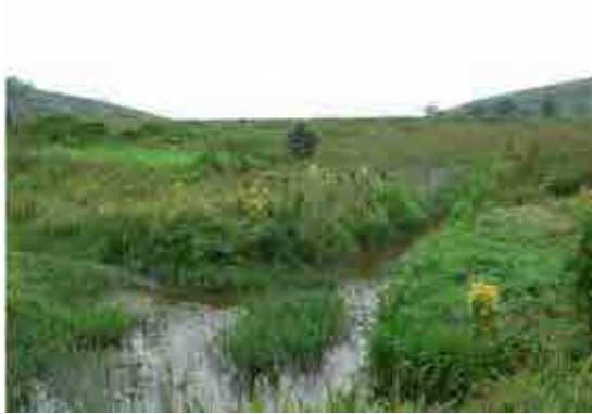
Point de confluence de l'écoulement issu du déversoir avec le canal d'évacuation, à 60 m en aval
